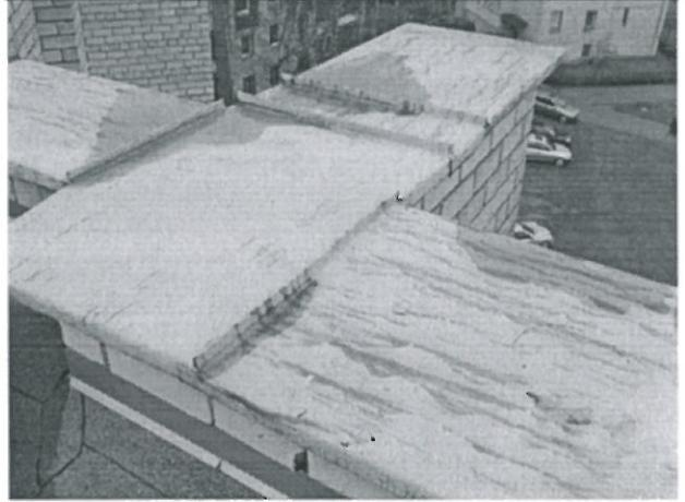
*Skardinimai pažeisti korozijos*
