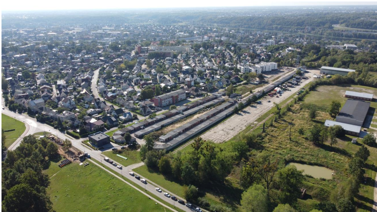
FF3.Esamos būklės fotofiksacija vietoje
