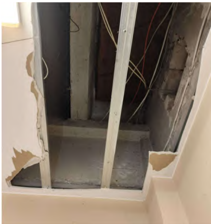
12 pav. Briaunota tarpaukštinė perdanga, surenkama g/b sija ir g/b kolona (2) zonoje
