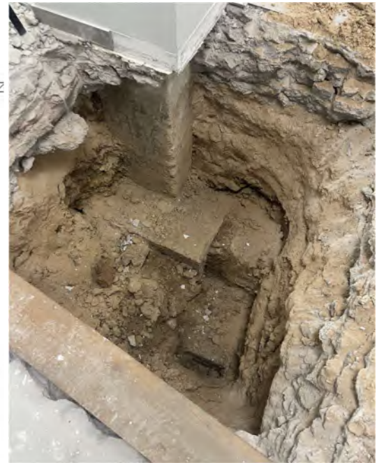
6 pav. Pamatų šūrfas ties kolona (1) zonoje
