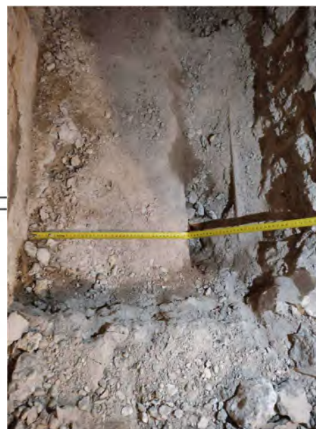
23 pav. Pastato Nr. 2 rūsio kolonos pamatas
