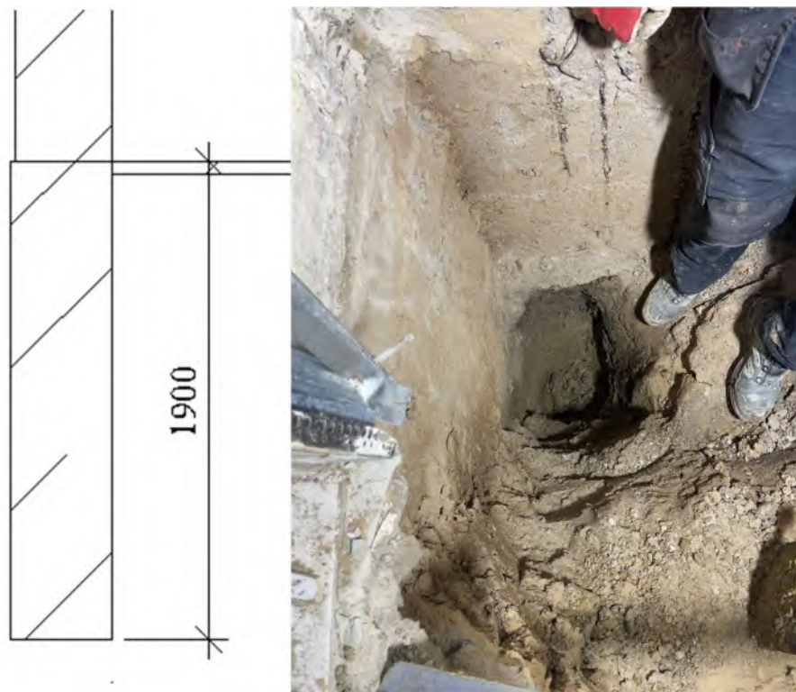
7 pav. Pamatų šūrfas ties išorine siena (2) zonoje
