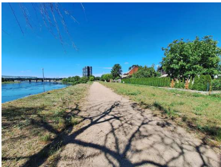
3 pav. Nemuno krantinės gatvės techninė būklė sausuoju periodu
