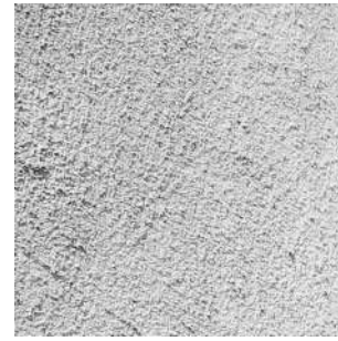
Pastato fasadams numatoma naudoti baltos spalvos vidutinio grubumo struktūrinį tinką, analogišką esamai situacijai
