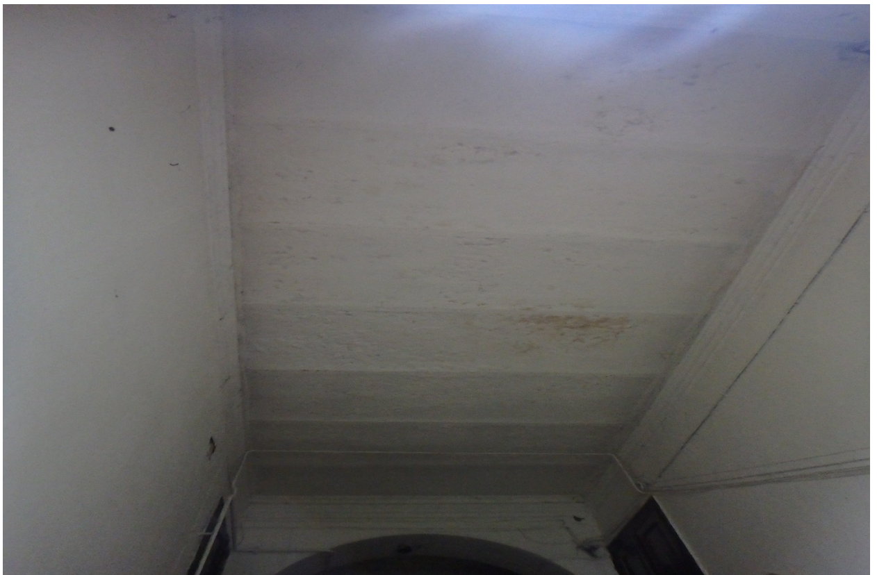
FF-24. Tinkuoto plytų mūro skliauteliai ant metalinių sijų perdangos
