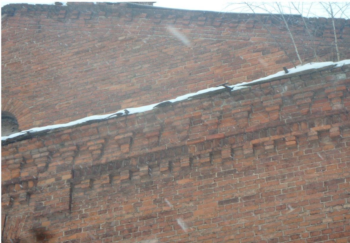
FF-13. Karnizo apskardinimo netektys, pradėję augti medžiai
