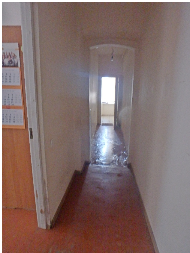
FF-28. Patalpų 1-3, 1-4 vaizdas.
