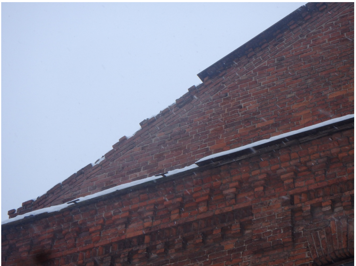
FF-12. Ugniasienės plytų netektis, apskardinimo trūkumas
