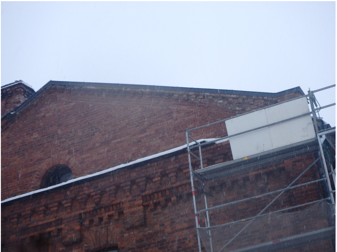
FF-10. Frontono karnizo apskardinimo keitimo vaizdas
