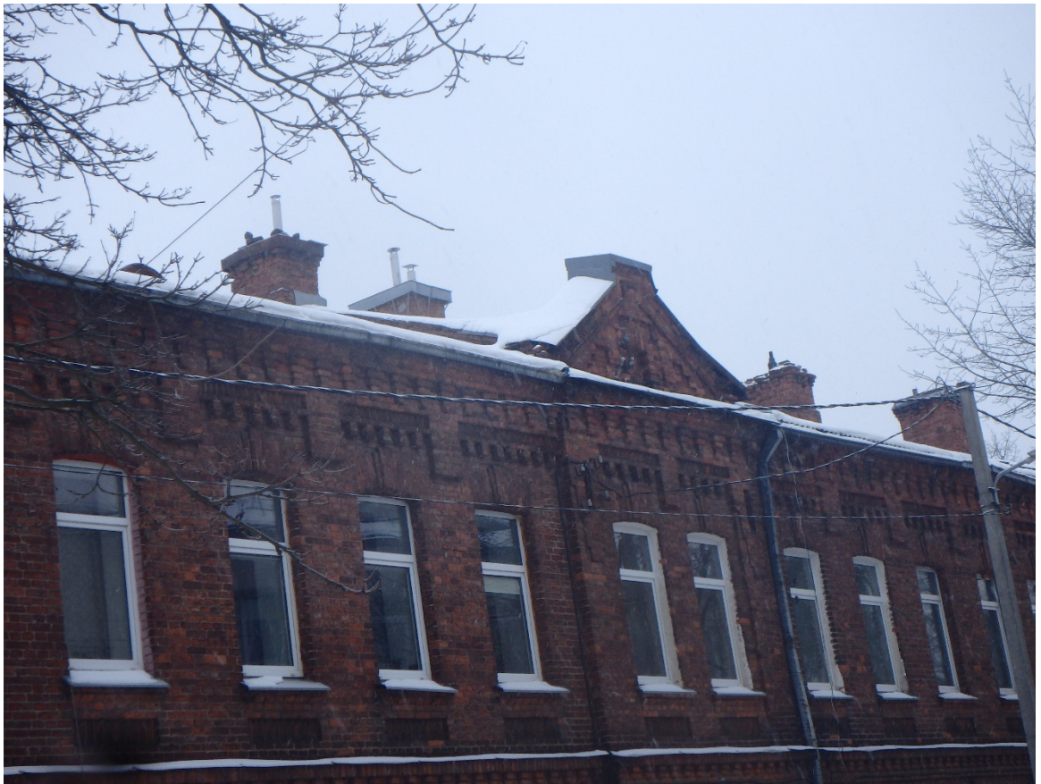
FF-11. Kamino karnizo plytų netektis, apskardinimo trūkumas
