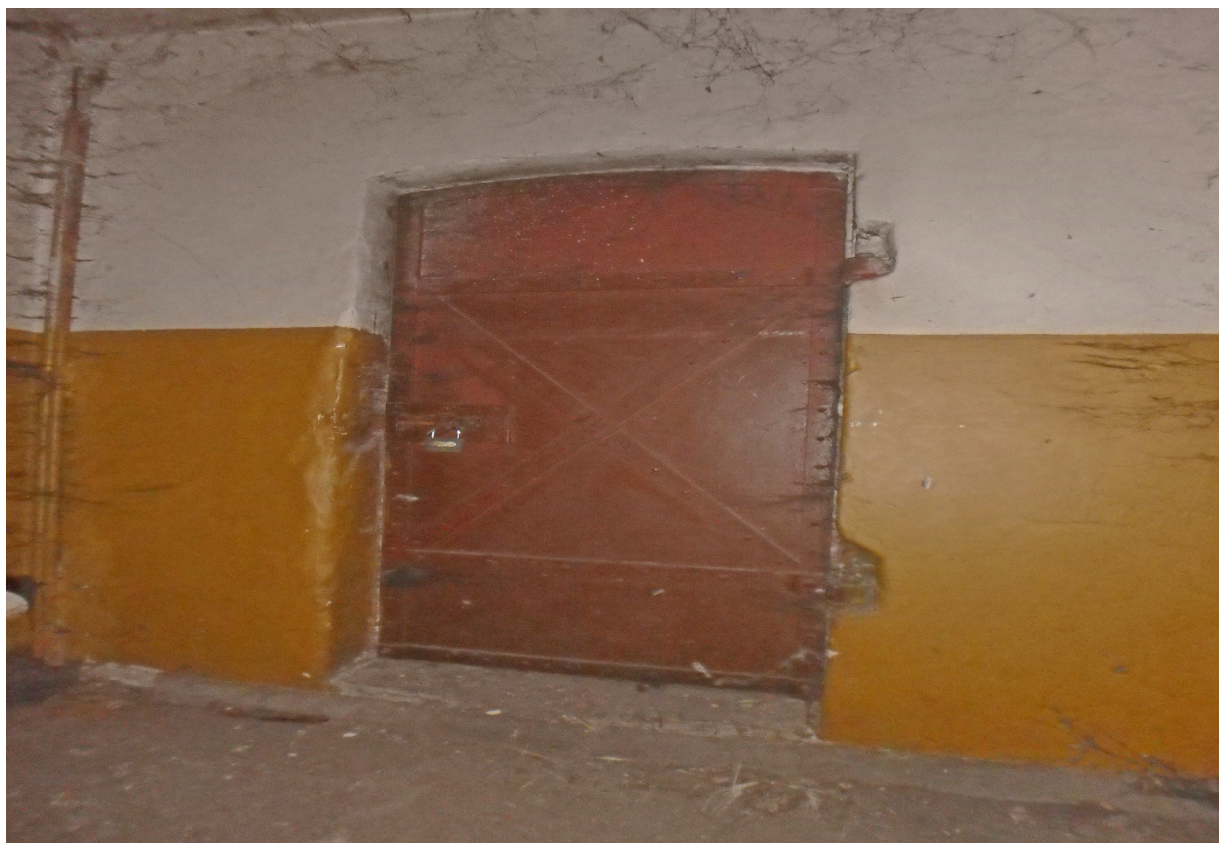
FF-20. Pastogės metalinės skydinės vienvėrės durys su metaliniais vyriais, apkaustais ir skląstimi
