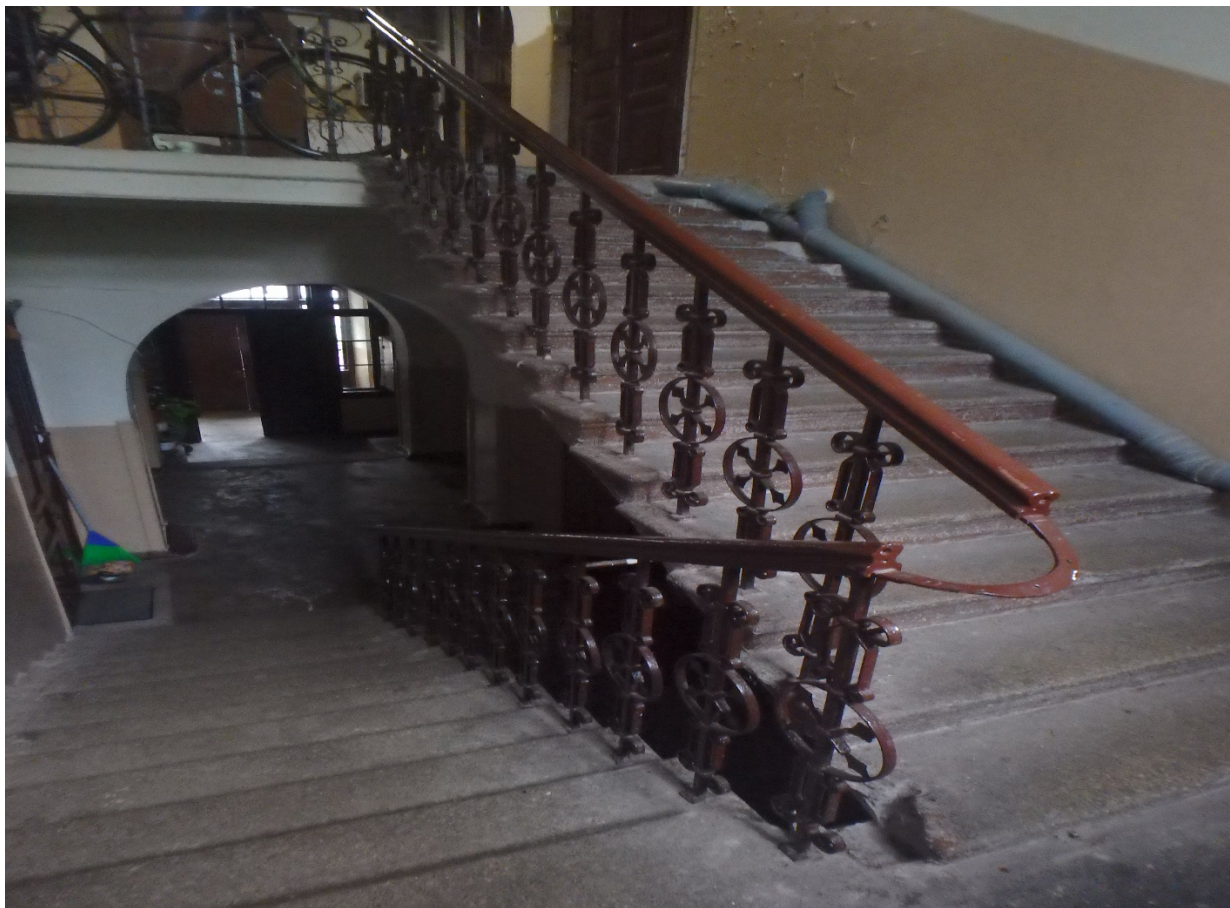
FF-19. PV laiptinės fragmentas. Metaliniai ažūriniai turėklai su mediniu porankiu
