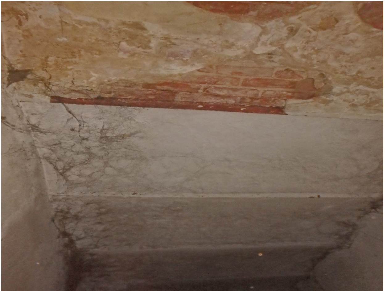
FF-23. ŠR laiptinės tinkuoto plytų mūro skliauteliai ant metalinių sijų perdangos fragmentas
