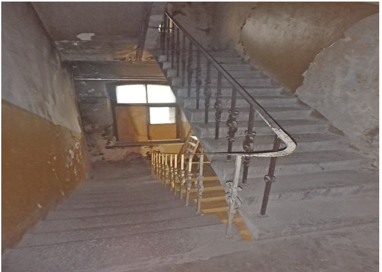
FF-18. ŠR laiptinės fragmentas. Metaliniai ažūriniai turėklai.
