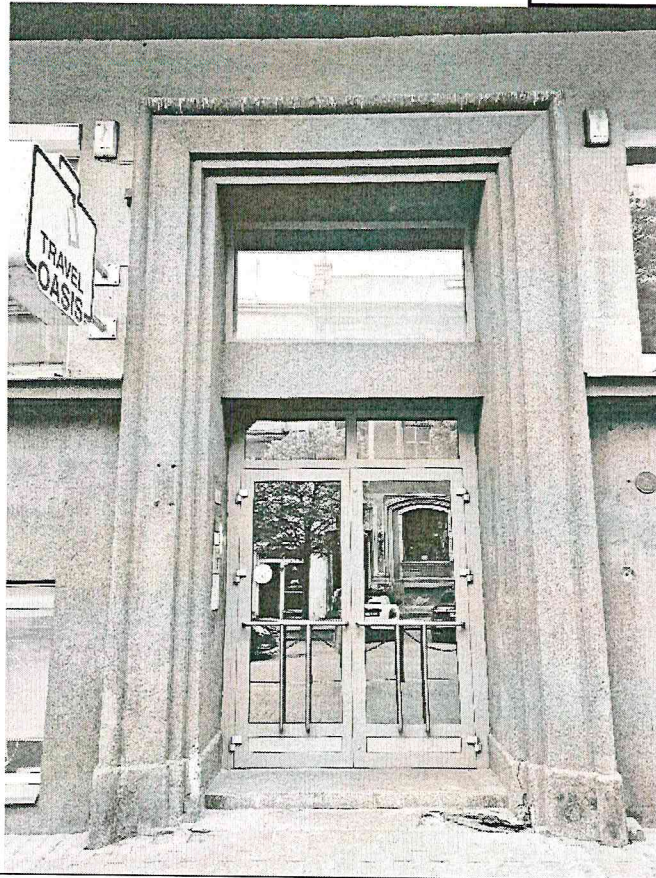
Nr. 3 Pavadinimas R fasado I a. įėjimo dirbtinio granito portalo su profiliuotu apvadu
