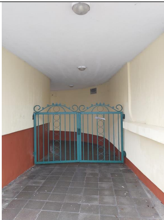
Nr. 16 Pavadinimas Žaliakalnio funikulieriaus statinių komplekso stotis Fotografavo Dovilė Miliukštė
