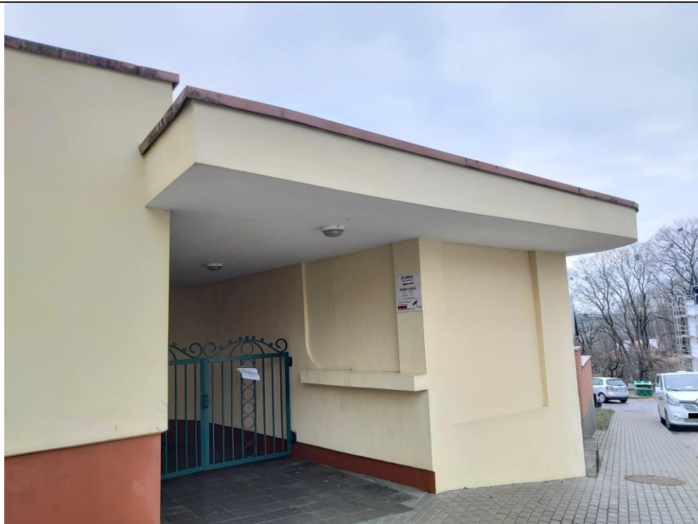
Nr. 15 Pavadinimas Žaliakalnio funikulieriaus statinių komplekso stotis Fotografavo Dovilė Miliukštė
