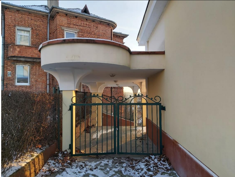
Nr. 9 Pavadinimas Žaliakalnio funikulieriaus statinių komplekso stotis Fotografavo Dovilė Miliukštė
