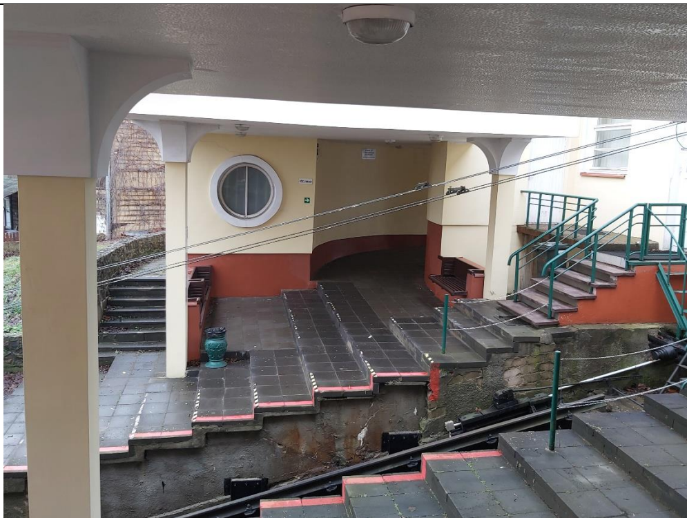
Nr. 10 Pavadinimas Žaliakalnio funikulieriaus statinių komplekso stotis Fotografavo Dovilė Miliukštė
