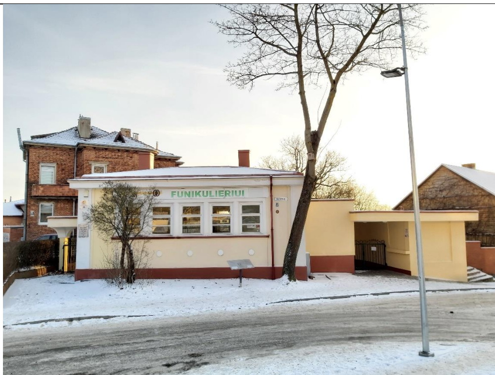
Nr. 1 Pavadinimas Žaliakalnio funikulieriaus statinių komplekso stotis Fotografavo Dovilė Miliukštė
