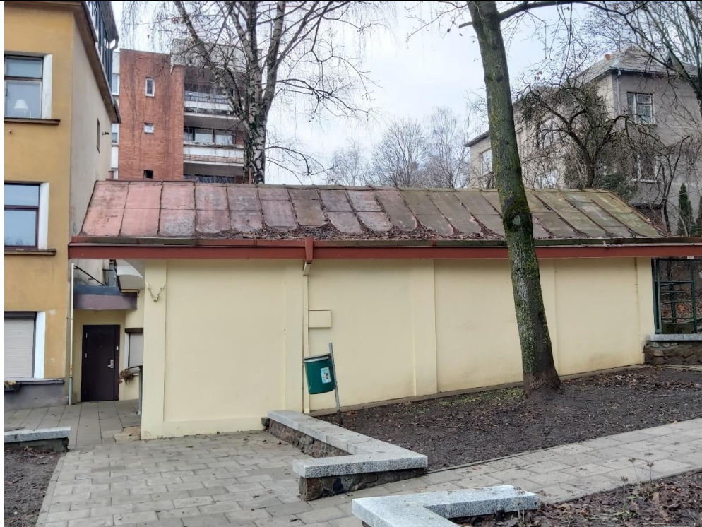
Nr. 7 Pavadinimas Žaliakalnio funikulieriaus statinių komplekso paviljonas Fotografavo Dovilė Miliukštė
