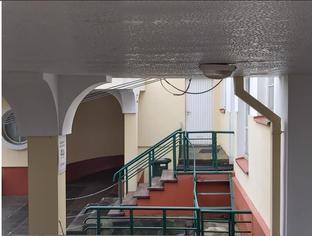
Nr. 11 Pavadinimas Žaliakalnio funikulieriaus statinių komplekso stotis Fotografavo Dovilė Miliukštė
