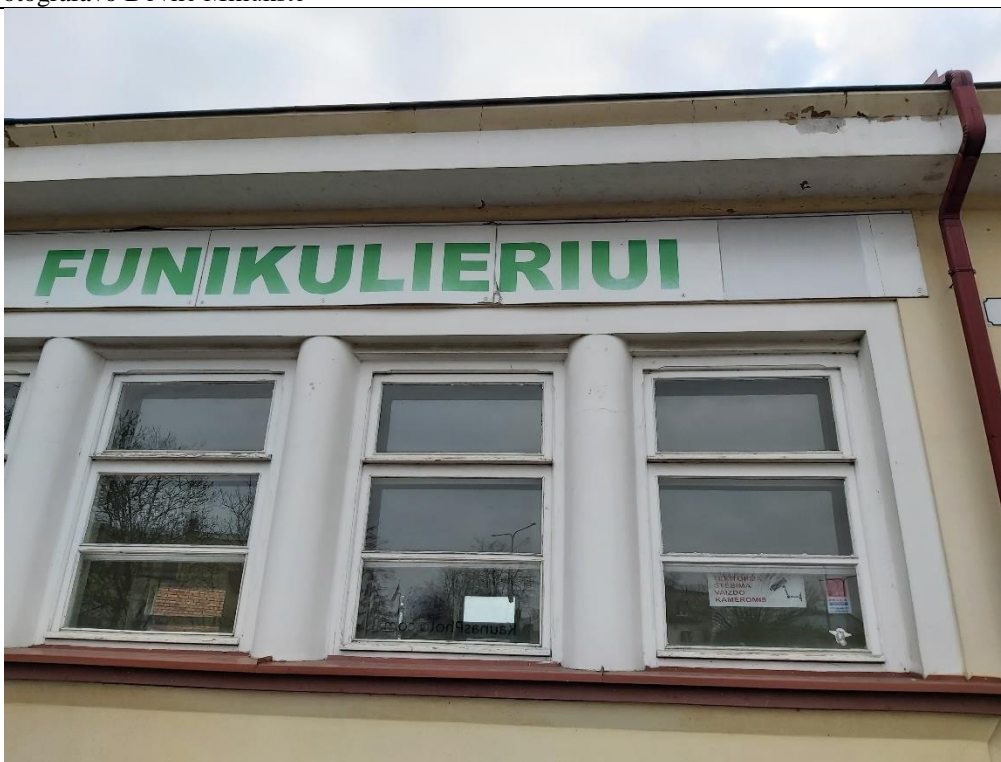
Nr. 2 Pavadinimas Žaliakalnio funikulieriaus statinių komplekso stotis Fotografavo Dovilė Miliukštė
