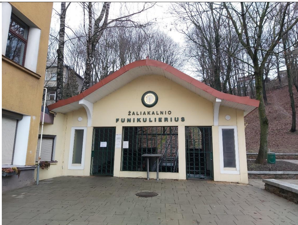
Nr. 6 Pavadinimas Žaliakalnio funikulieriaus statinių komplekso paviljonas Fotografavo Dovilė Miliukštė
