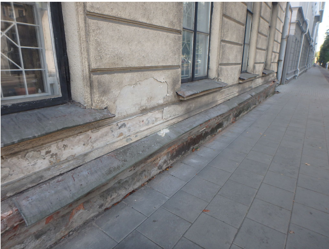
FF-6. Š fasado fragmentas. Nusilupęs tinkas, blogėjanti apskardinių būklė.
