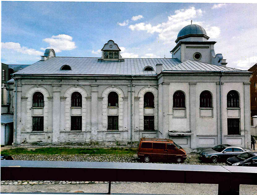
FF-22. ŠV fasadas, stogo elementai.
