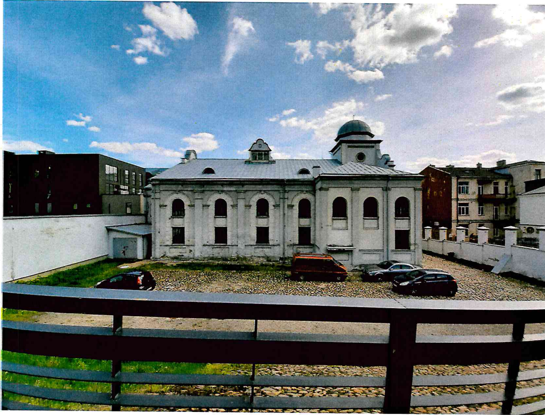
FF-21. ŠV fasadas, aplinka, stogo elementai.
