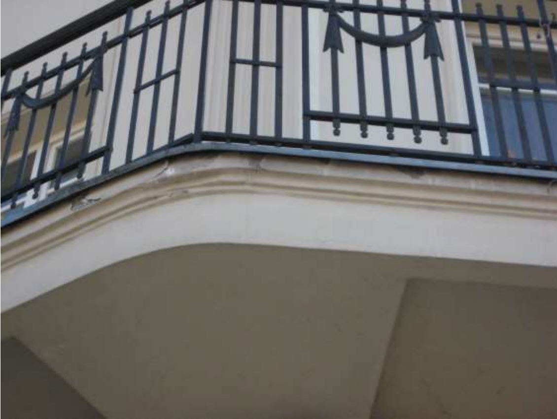
FF-26. Tinko pažeidimai po skardos laštakiu
