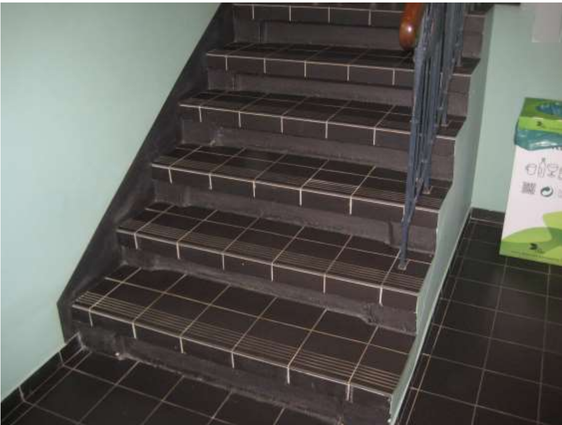
FF-6. Laiptai, apklijuoti keraminėmis plytelėmis
