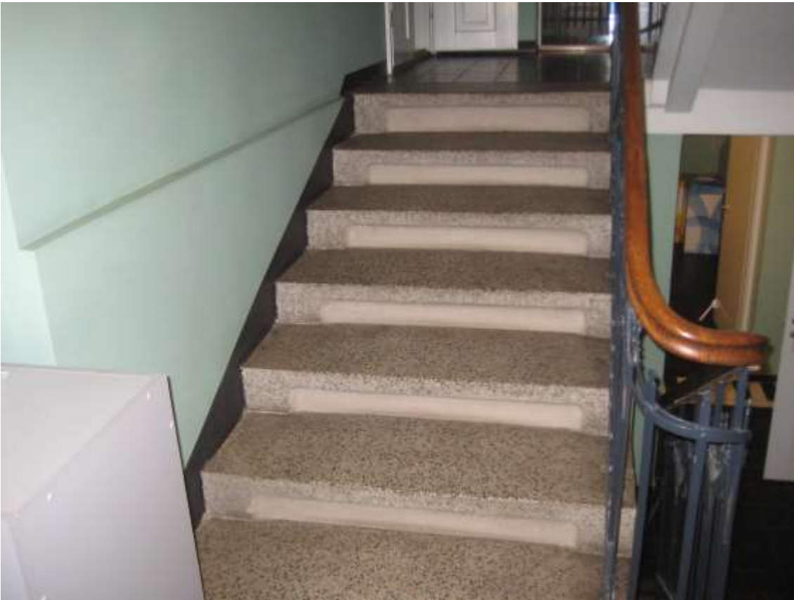
FF-5. Teraco pakopos ant metalinės laiptų konstrukcijos
