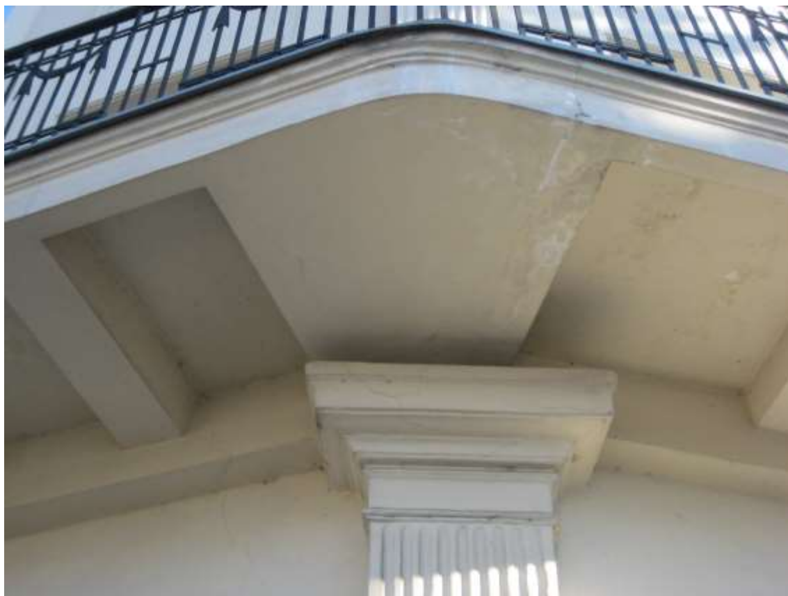
FF-25. Tinko pažeidimai ties balkono apačia
