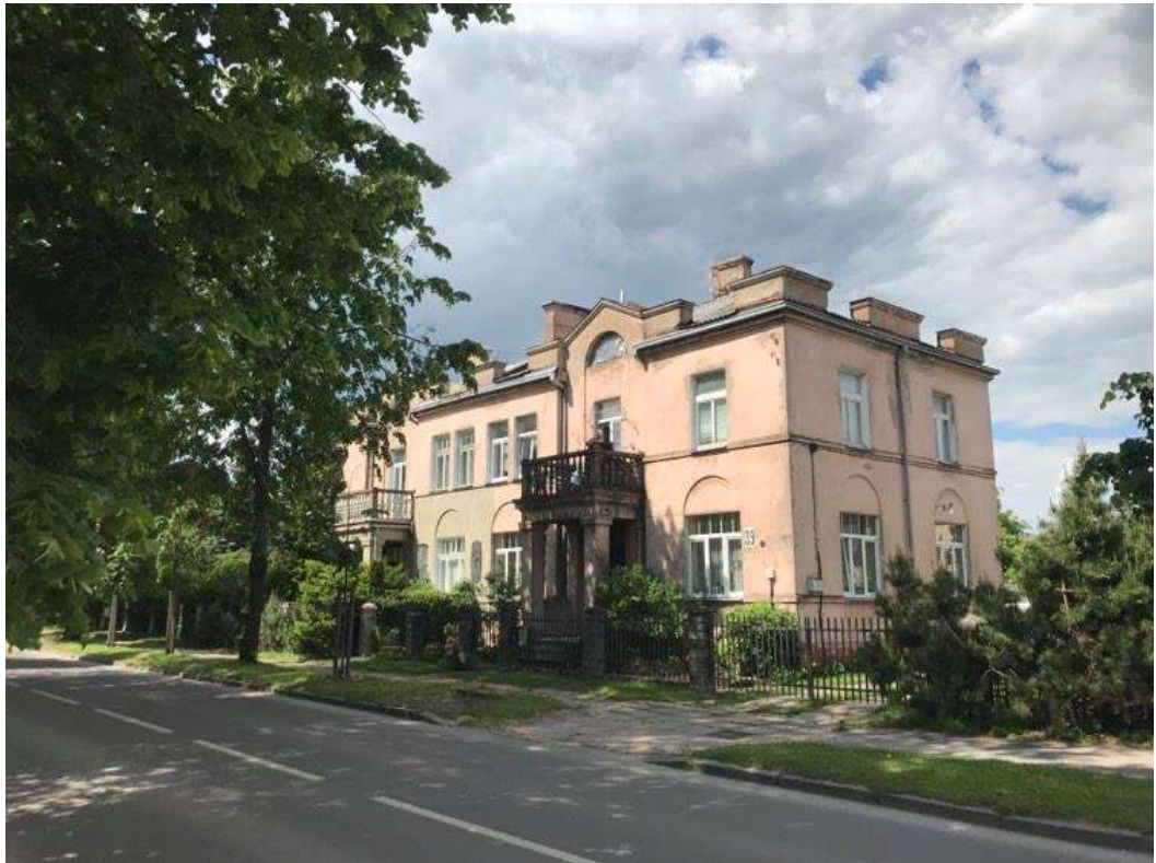
Nr. 1 Pavadinimas Namų pagrindinis fasadas Fotografavo Dovilė Miliukštė Data 2021-06-21
