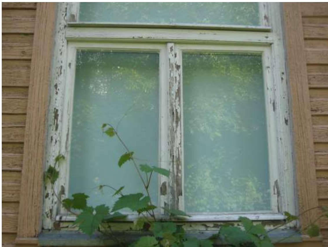
FF-17. Atmosferos poveikio pažeista medinių langų danga
