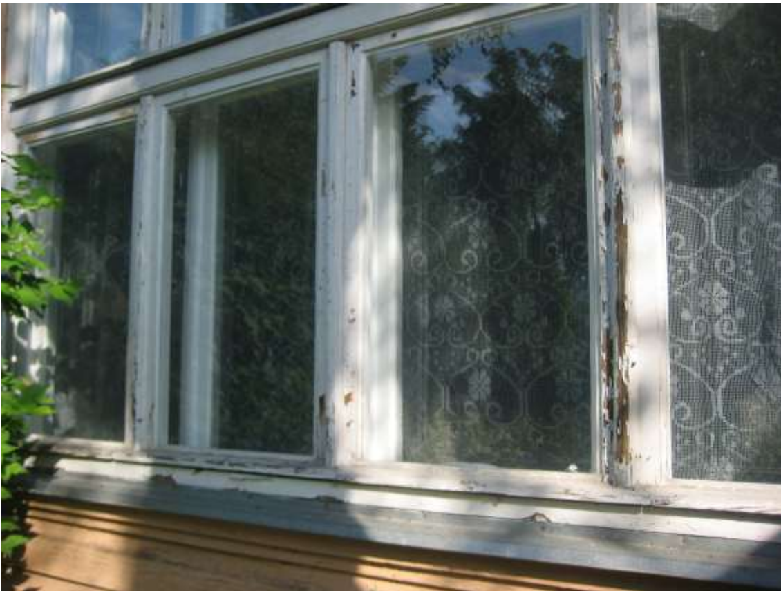
FF-16. Atmosferos poveikio pažeista medinių langų danga
