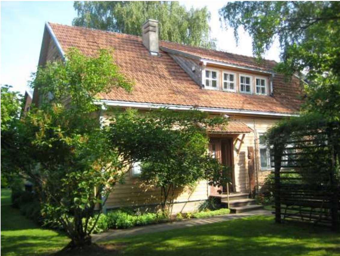
FF-13. Namo fasadas iš Kalniečių g. pusės
