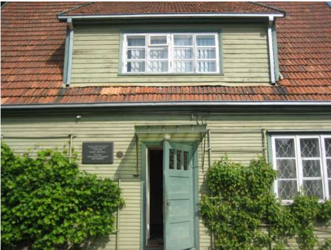
FF-14. Matomos pažeistos stoglangio dailylentės, nesandarios durys
