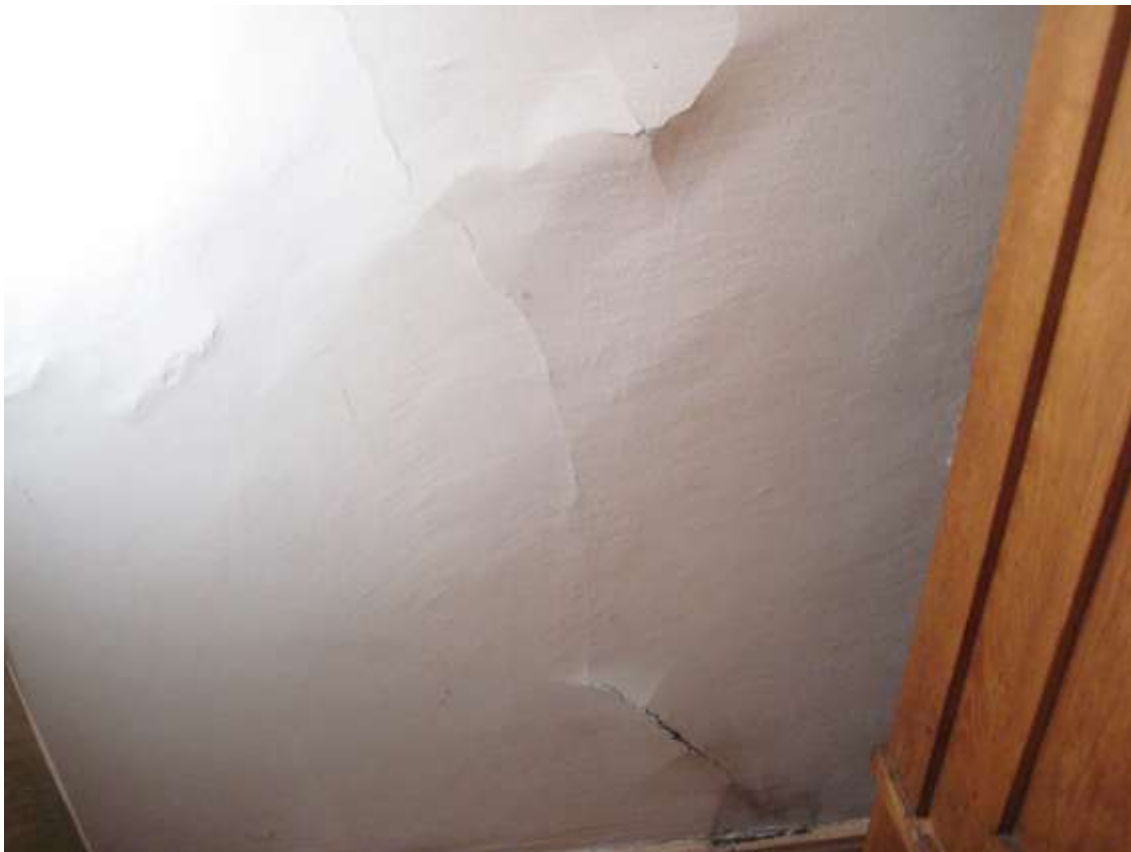
FF-9. Suskilinėjės ir atšokės lubų tinkas
