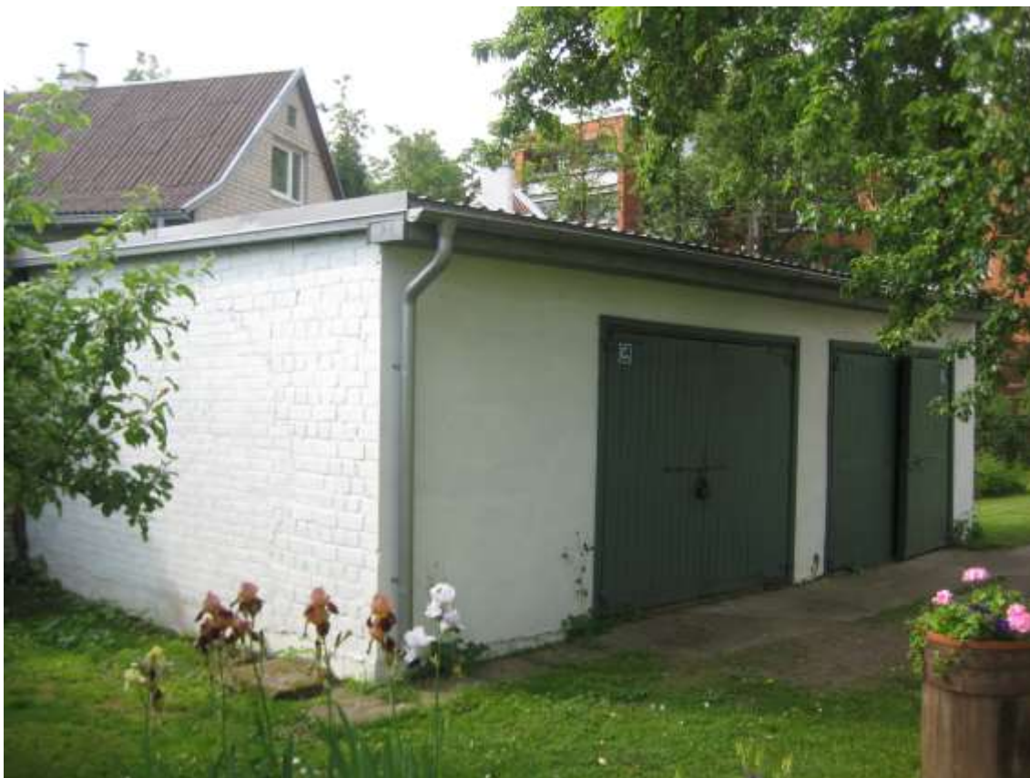
FF-21. Sklypui priklausantis mūrinis garažas
