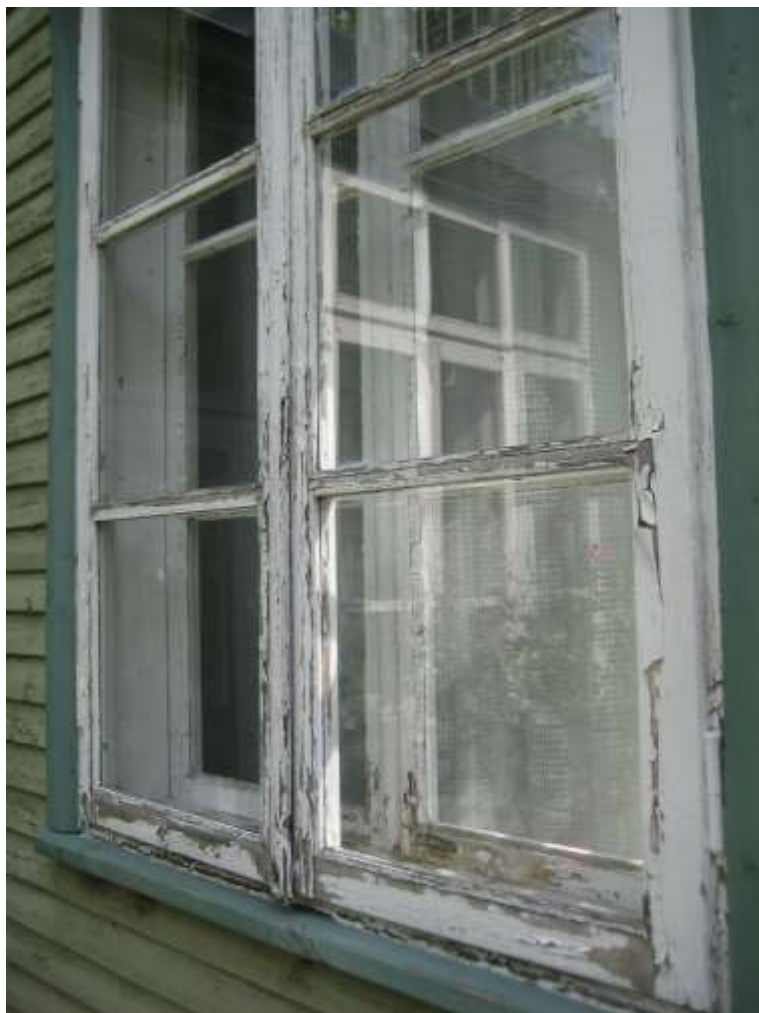
FF-15. Atmosferos poveikio pažeista medinių langų danga
