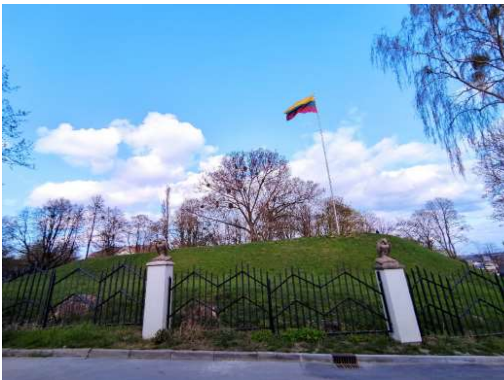
Nr. 4 Pavadinimas Kauno tvirtovės 9-osios baterijos liekanų komplekso baterijos liekanos Fotografavo K. Muravjovaitė ir S. Dikaitė Data 2021-04-29
