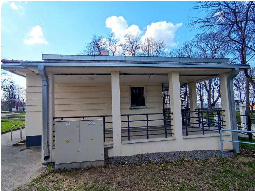
Nr. 4 Pavadinimas Aleksoto funikulieriaus statinių komplekso stotis Fotografavo Skaistė Dikaite ir Kamilė Muravjovaitė Data 2021-04-28
