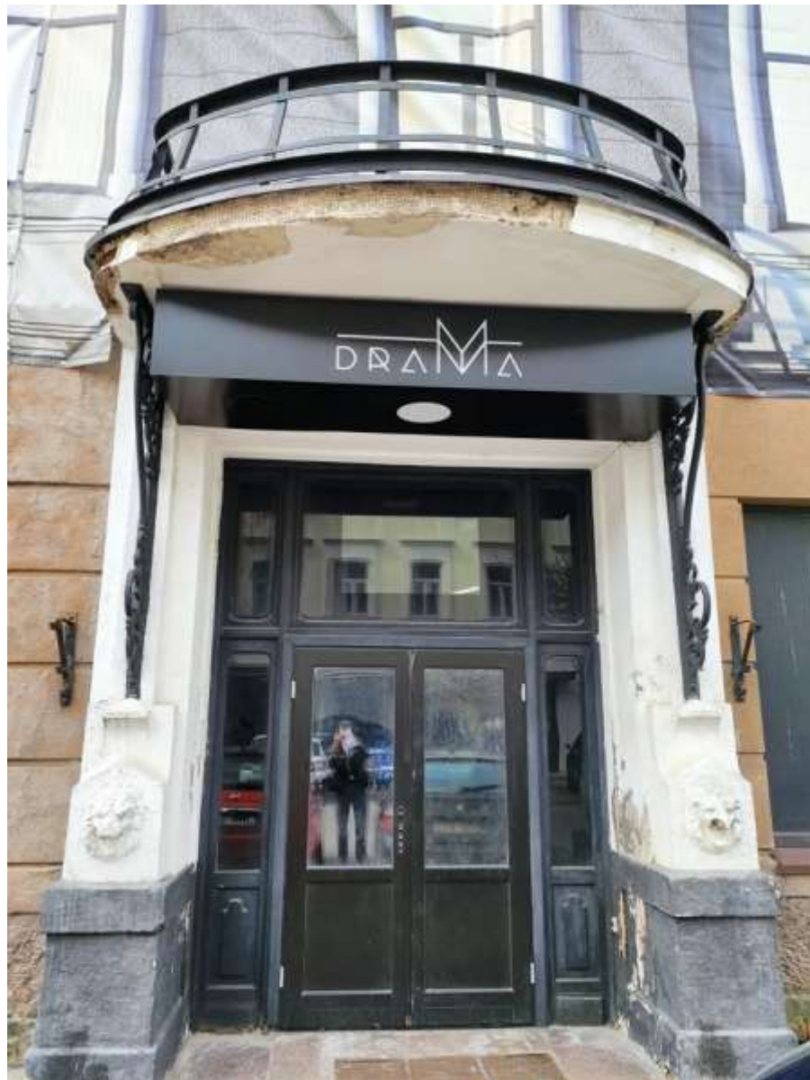
Nr. 7 Pavadinimas Viešbučio "Versalis" pastatų komplekso Pirmas pastatas Fotografavo Kamilė Muravjovaitė ir Skaistė Dikaitė. Data 2021-04-13
