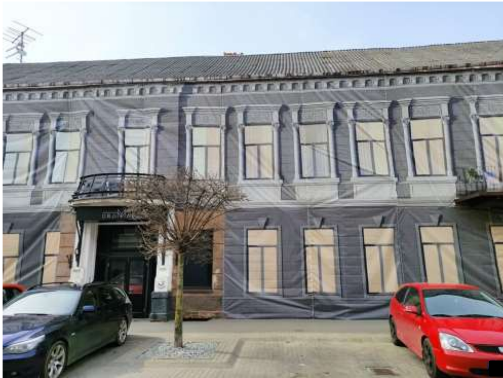
Nr. 3 Pavadinimas Viešbučio "Versalis" pastatų kompleksas Fotografavo Kamilė Muravjovaitė ir Skaistė Dikaitė. Data 2021-04-13
