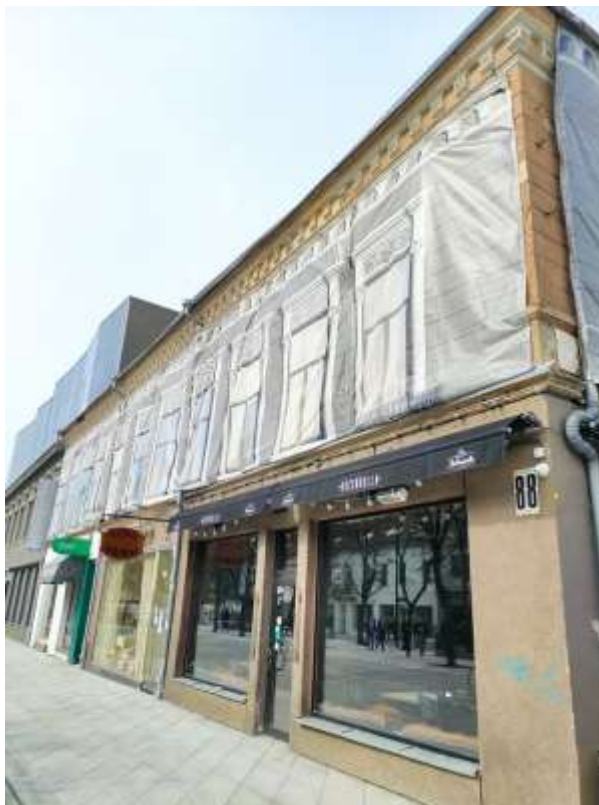
Nr. 1 Pavadinimas Viešbučio "Versalis" pastatų kompleksas Fotografavo Kamilė Muravjovaitė ir Skaistė Dikaitė. Data 2021-04-13
