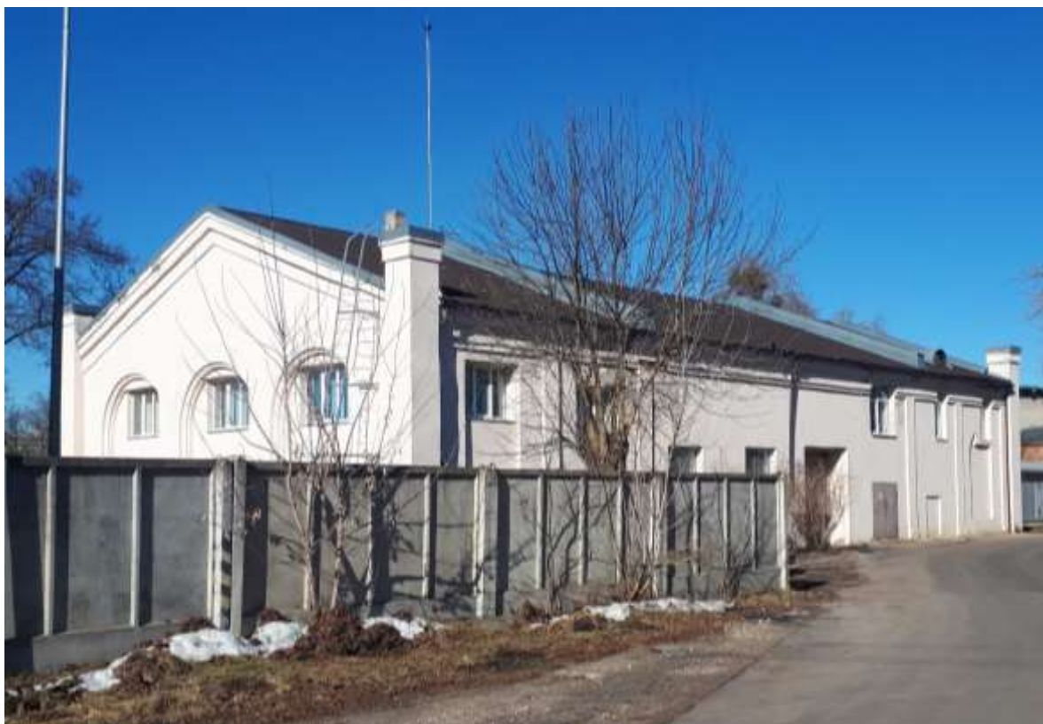
FOTOFIKSACIJA. Kauno depo statinių komplekso elektrinės pastatas. Fotografavo – Asta Raškevičiūtė-Šimkevičienė, 2021-03-05.
