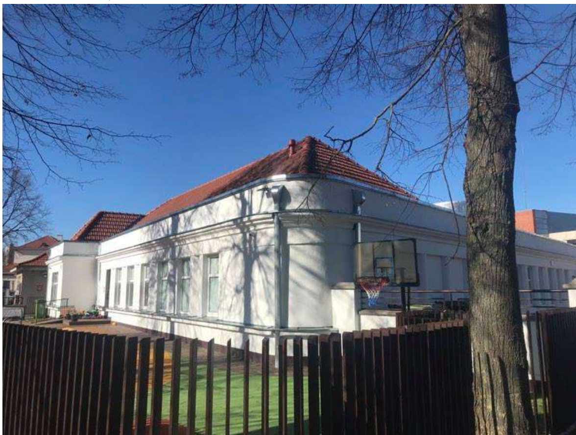
FOTOFIKSACIJA. Kauno Žaliakalnio vandentiekio stoties pastatų komplekso ūkinis pastatas. Fotografavo – Dovilė Miliukštė, 2021-03-05.
