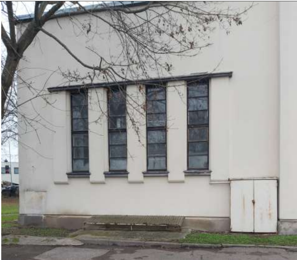
Nr. 13 Pavadinimas Ginklavimo valdybos tyrimų laboratorijos pastatų komplekso ūkinis pastatas Fotografavo Danguolė Jonušaitė Data 2021-11-05
