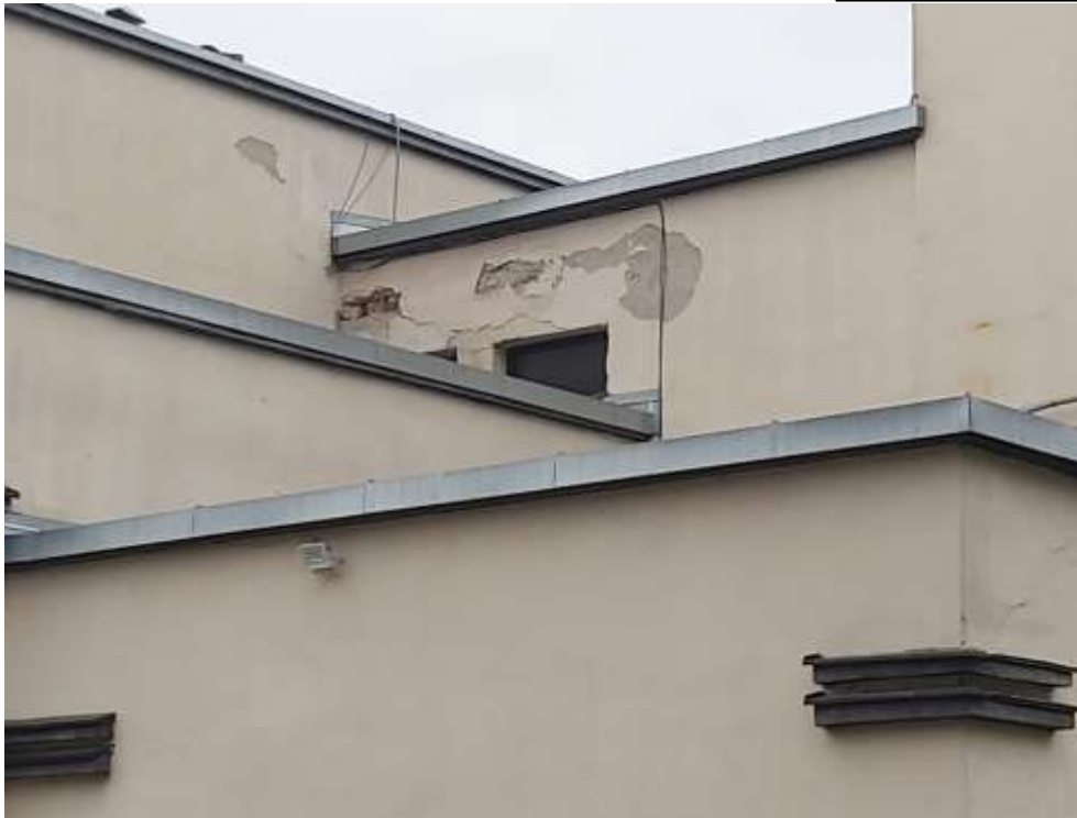
Nr. 7 Pavadinimas Ginklavimo valdybos tyrimų laboratorijos pastatų komplekso ūkinis pastatas Fotografavo Danguolė Jonušaitė Data 2021-11-05
