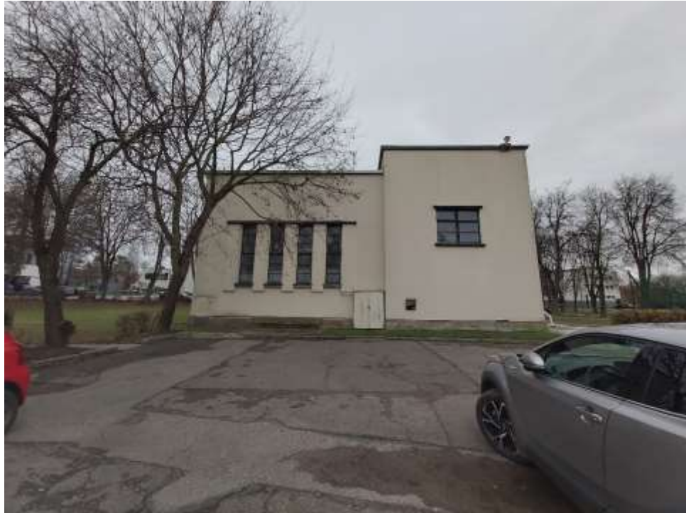
Nr. 12 Pavadinimas Ginklavimo valdybos tyrimų laboratorijos pastatų komplekso ūkinis pastatas Fotografavo Danguolė Jonušaitė Data 2021-11-05
