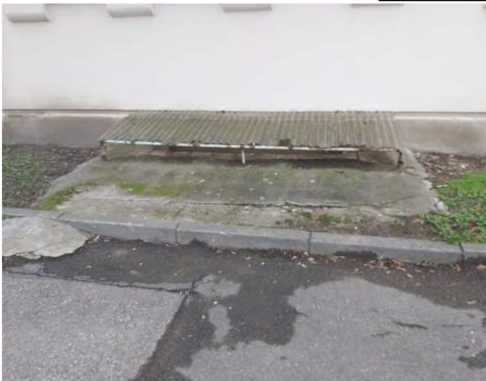
Nr. 14 Pavadinimas Ginklavimo valdybos tyrimų laboratorijos pastatų komplekso ūkinis pastatas Fotografavo Danguolė Jonušaitė Data 2021-11-05
