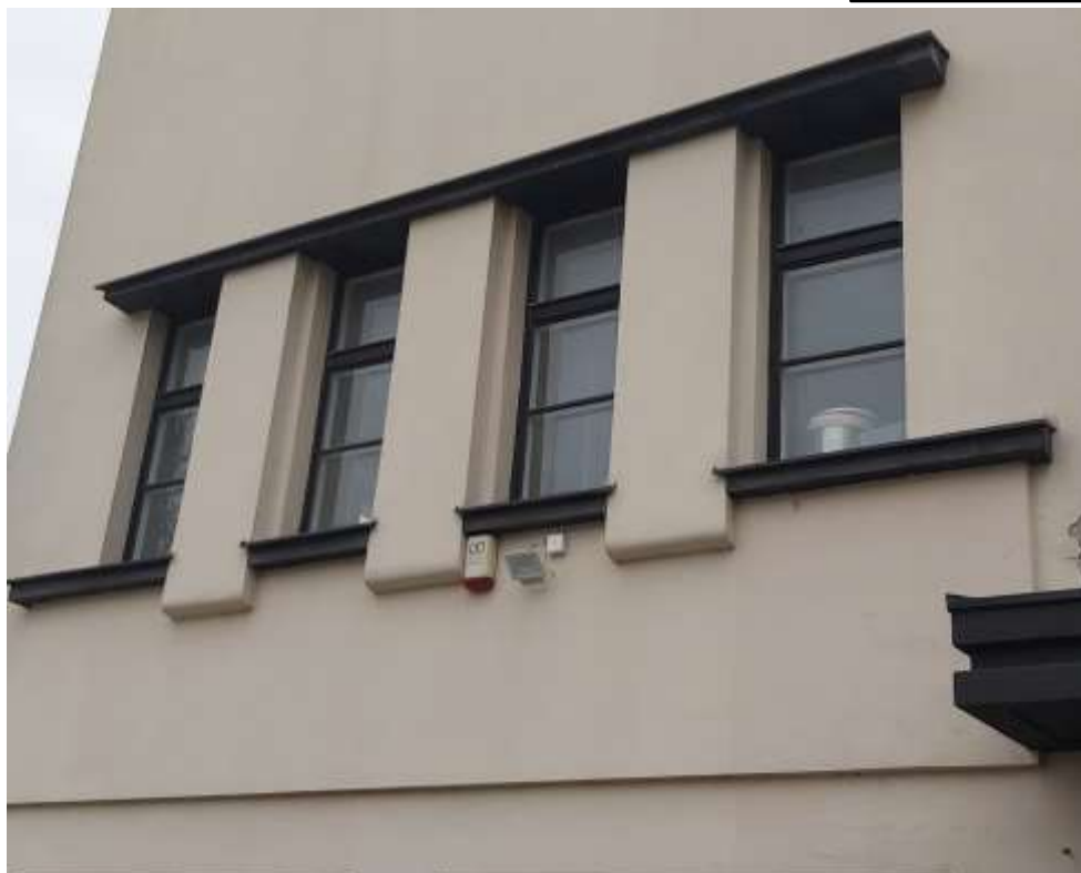
Nr. 10 Pavadinimas Ginklavimo valdybos tyrimų laboratorijos pastatų komplekso ūkinis pastatas Fotografavo Danguolė Jonušaitė Data 2021-11-05
