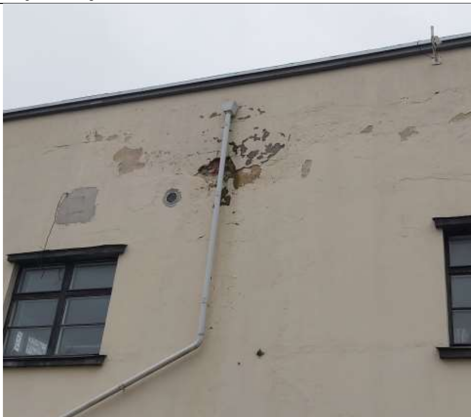
Nr. 11 Pavadinimas Ginklavimo valdybos tyrimų laboratorijos pastatų komplekso ūkinis pastatas Fotografavo Danguolė Jonušaitė Data 2021-11-05
