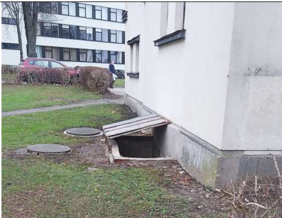
Nr. 15 Pavadinimas Ginklavimo valdybos tyrimų laboratorijos pastatų komplekso ūkinis pastatas Fotografavo Danguolė Jonušaitė Data 2021-11-05
