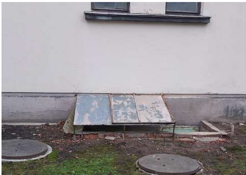
Nr. 16 Pavadinimas Ginklavimo valdybos tyrimų laboratorijos pastatų komplekso ūkinis pastatas Fotografavo Danguolė Jonušaitė Data 2021-11-05
