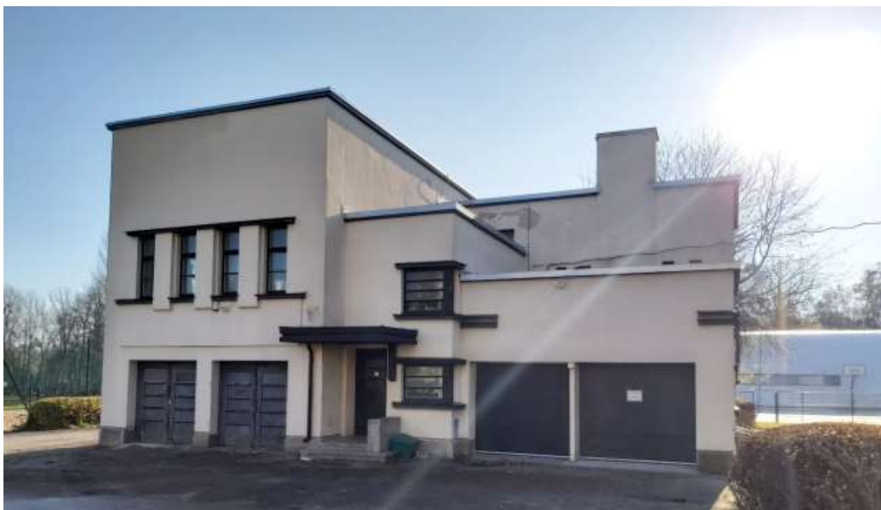
Nr. 3 Pavadinimas Ginklavimo valdybos tyrimų laboratorijos pastatų komplekso ūkinis pastatas Fotografavo Danguolė Jonušaitė Data 2021-11-05
