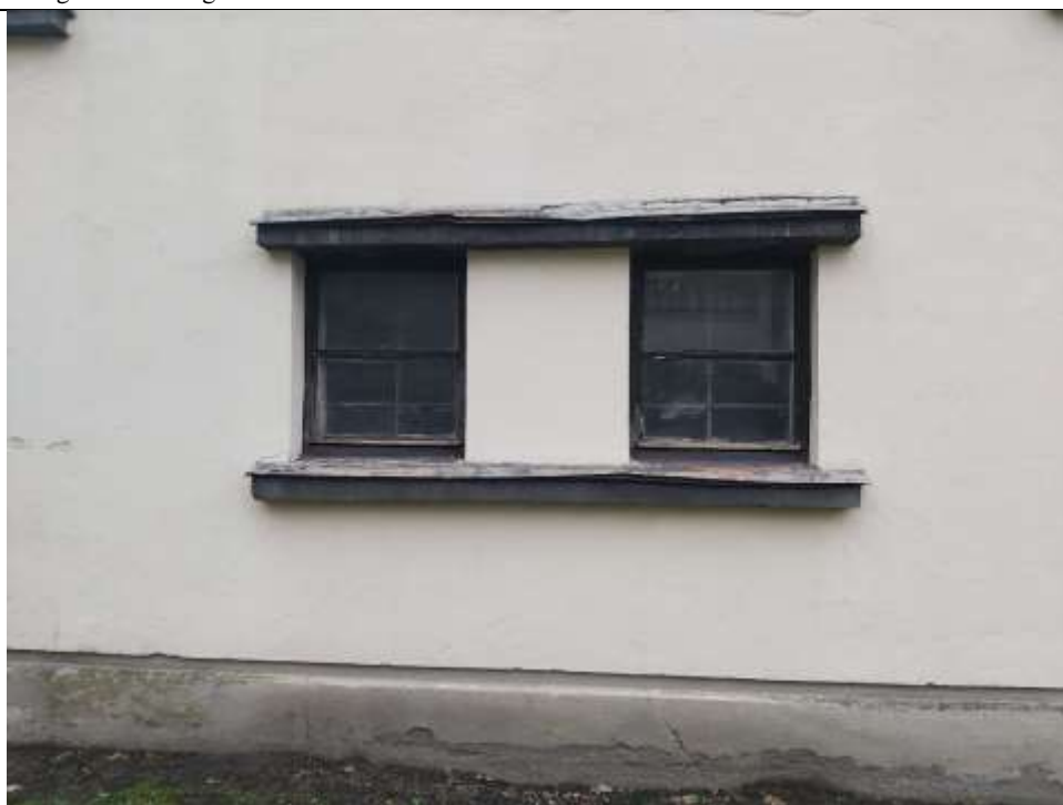
Nr. 17 Pavadinimas Ginklavimo valdybos tyrimų laboratorijos pastatų komplekso ūkinis pastatas Fotografavo Danguolė Jonušaitė Data 2021-11-05
