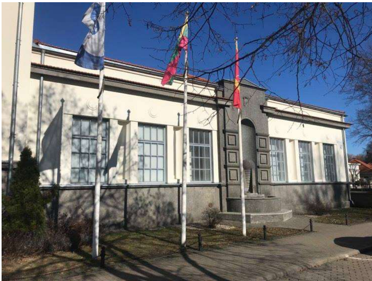
FOTOFIKSACIJA. Kauno Žaliakalnio vandentiekio stoties pastatų komplekso siurblinė. Fotografavo – Dovilė Miliukštė, 2021-03-05.
