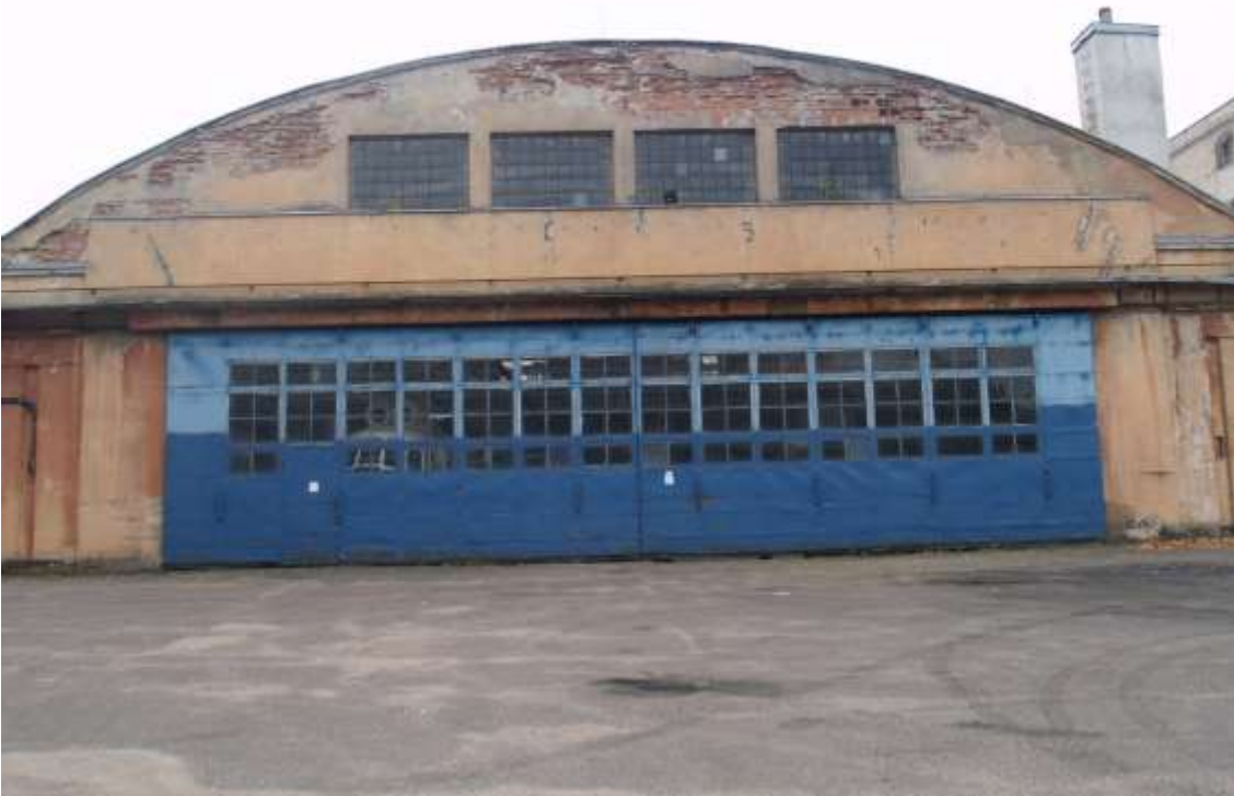
FF-5. Ši fasadas su matomais mūro pažeidimais pusapskritėje sienos dalyje
