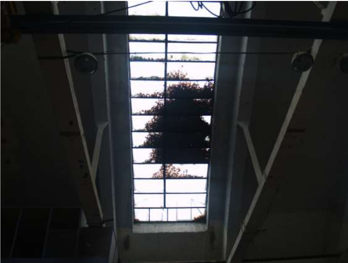
FF-13. Ant stoglangio sunešta lapų krūva, kuri neigiamai veikia stogo konstrukcijas
