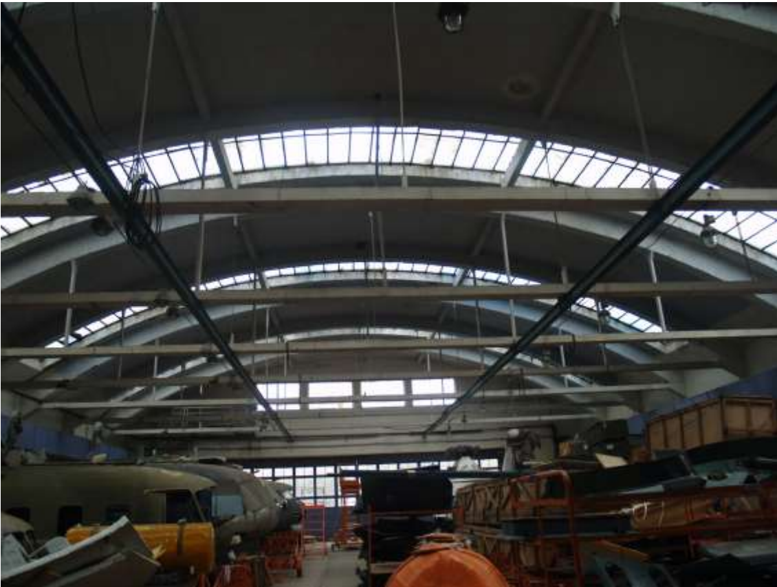
FF-11. Angaro vidaus gelžbetoninės stogo konstrukcijos
