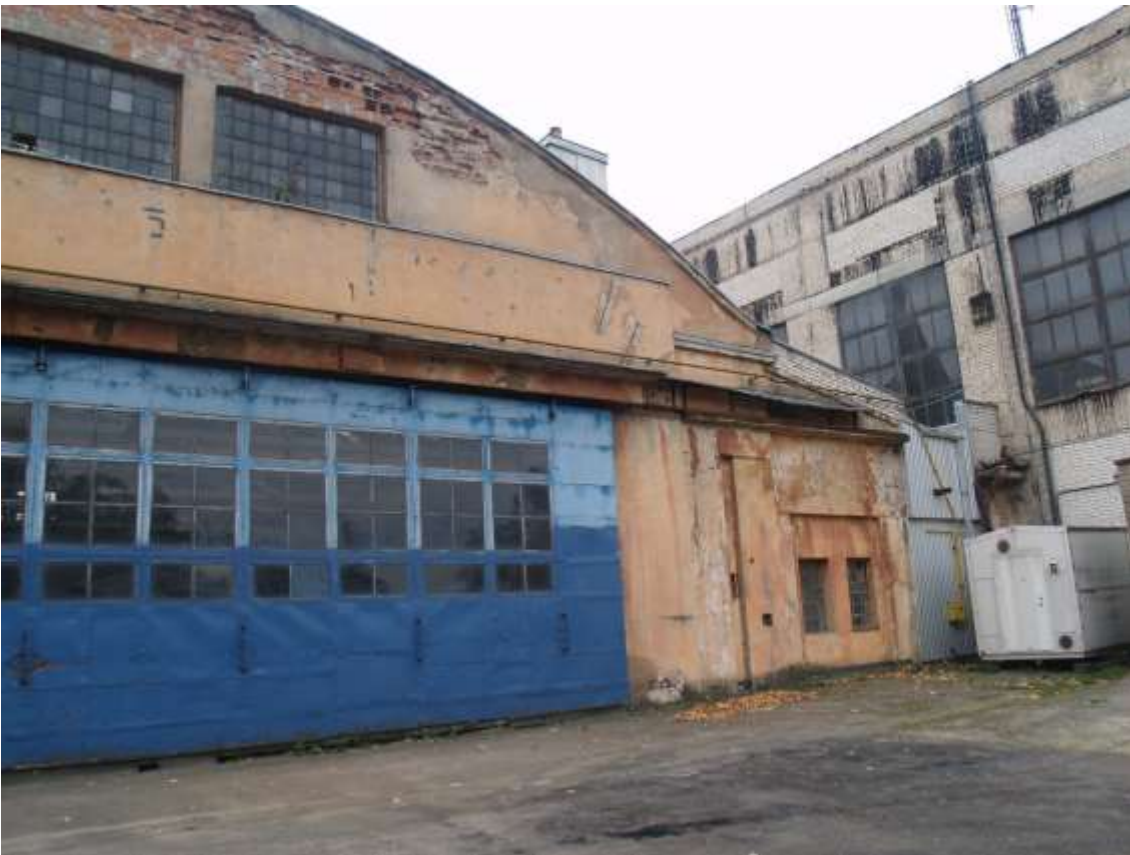
FF-8. Kraštinėje dalyje, ant esamos sienos, primūrytas naujas parapetas
