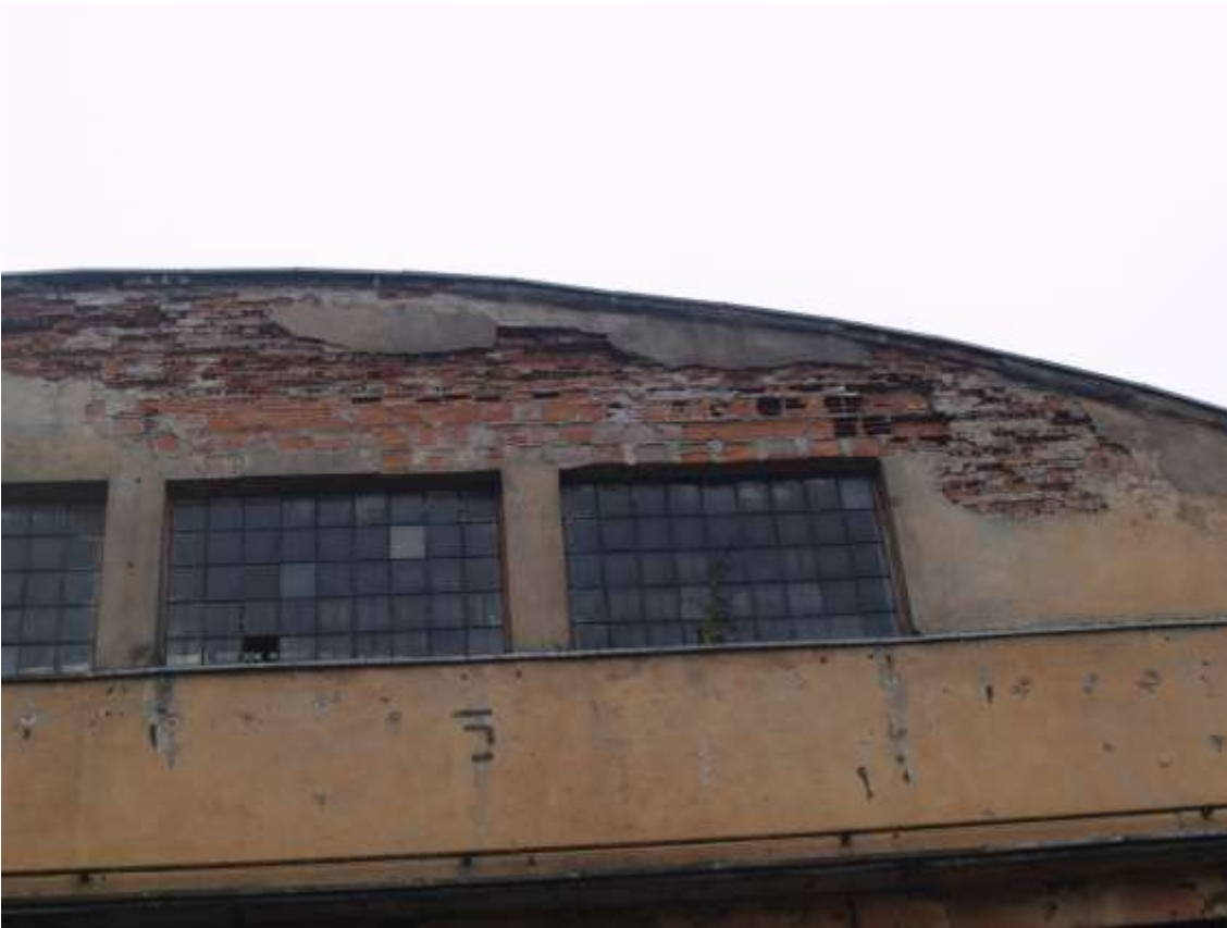
FF-6. Stipriai drėgmės pažeisti keraminiai skylėti sienos blokeliai
