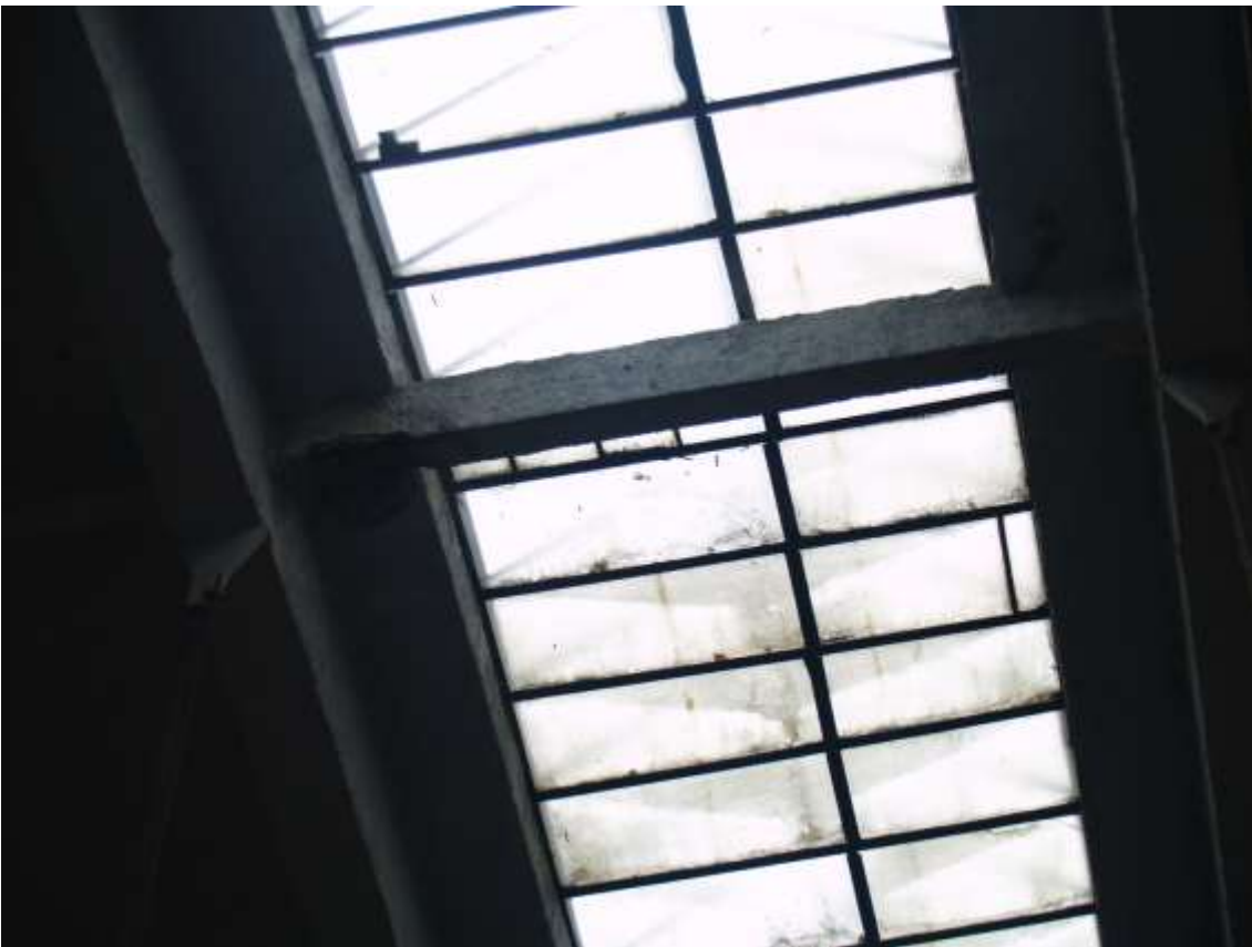
FF-12. Stogo g/b elementas nutrupėjęs, atsidengusi jo armatūra
