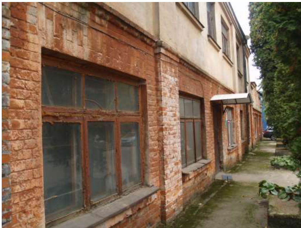
Nr. 3 Pavadinimas Karo aviacijos dirbtuvių pastatų komplekso metalo dirbtuvės Fotografavo Dovilė Miliukštė Data 2021-10-13
