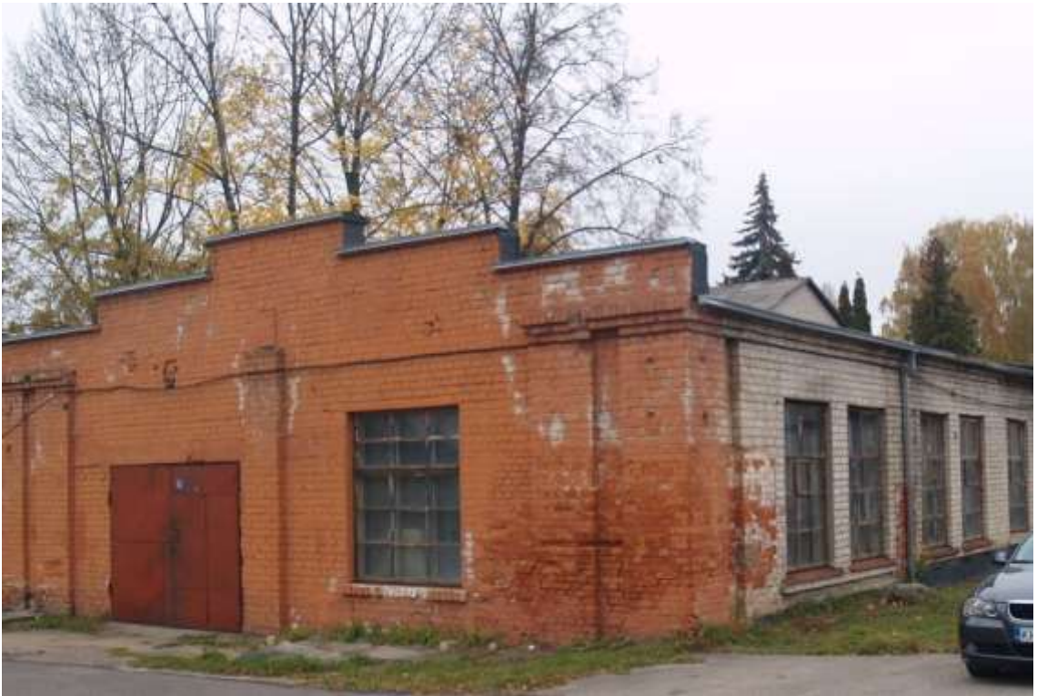
Nr. 1 Pavadinimas Karo aviacijos dirbtuvių pastatų komplekso metalo dirbtuvės Fotografavo Dovilė Miliukštė Data 2021-10-13
