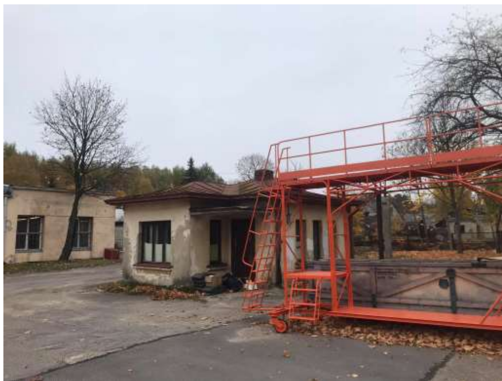
Nr. 6 Pavadinimas Karo aviacijos dirbtuvių pastatų kompleksas Fotografavo Dovilė Miliukštė 2021-10-13
