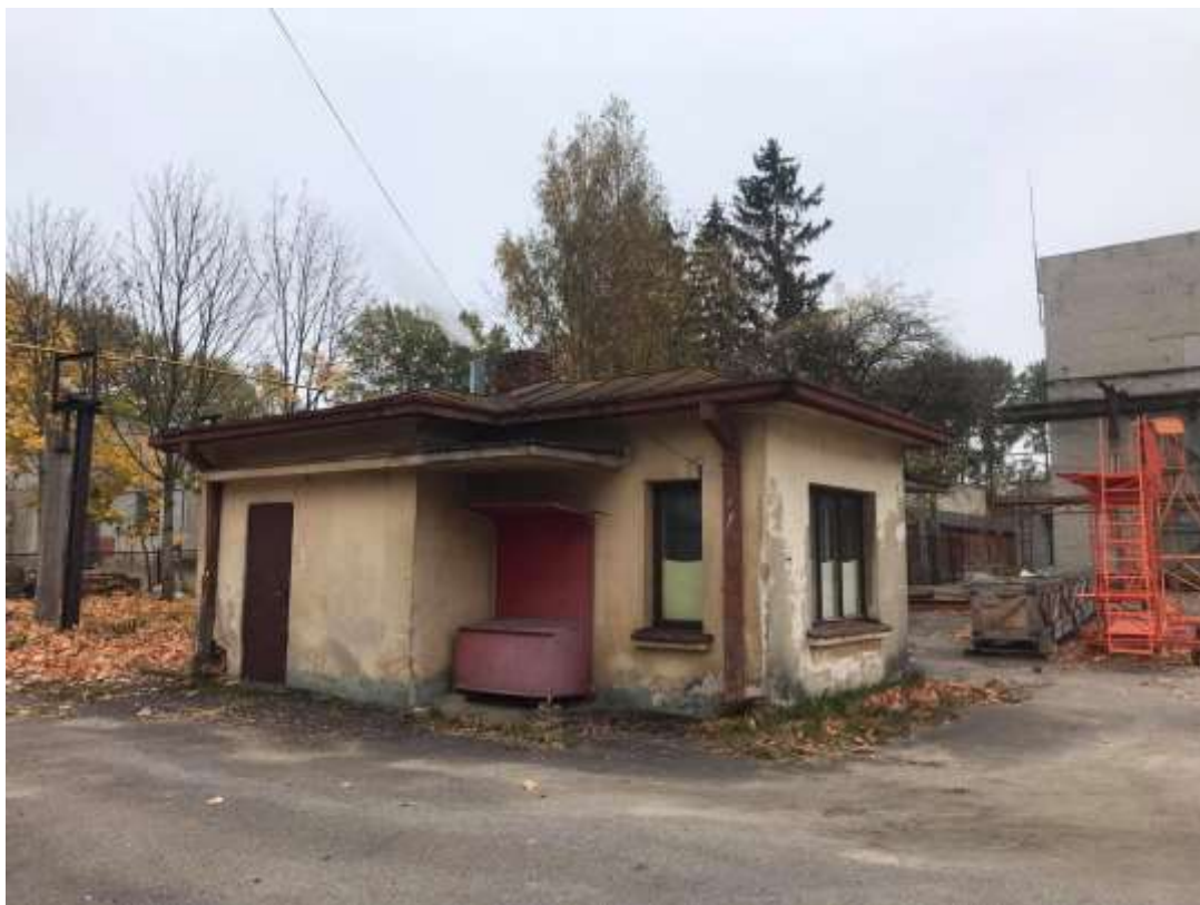
Nr. 3 Pavadinimas Karo aviacijos dirbtuvių pastatų komplekso sarginė Fotografavo Dovilė Miliukštė Data 2021-10-13
