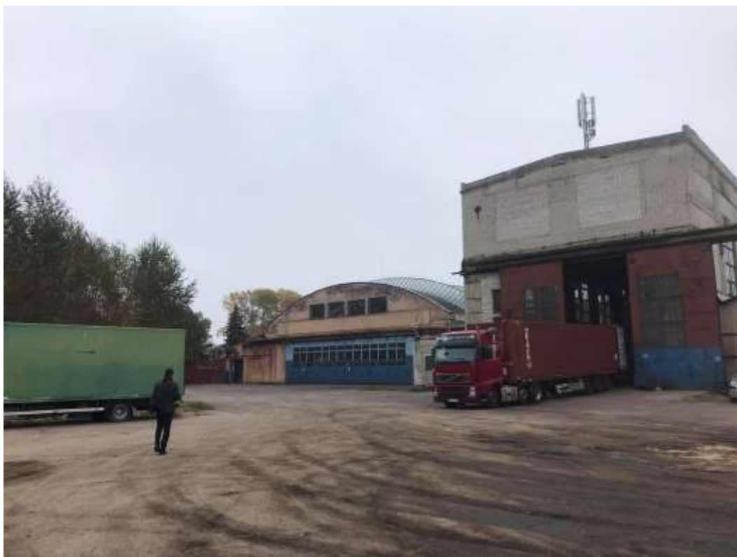
Nr. 8 Pavadinimas Karo aviacijos dirbtuvių pastatų kompleksas Fotografavo Dovilė Miliukštė 2021-10-13
