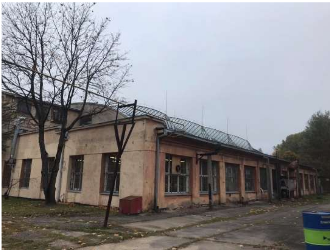
Nr. 4 Pavadinimas Karo aviacijos dirbtuvių pastatų komplekso angaras Fotografavo Dovilė Miliukštė 2021-10-13
