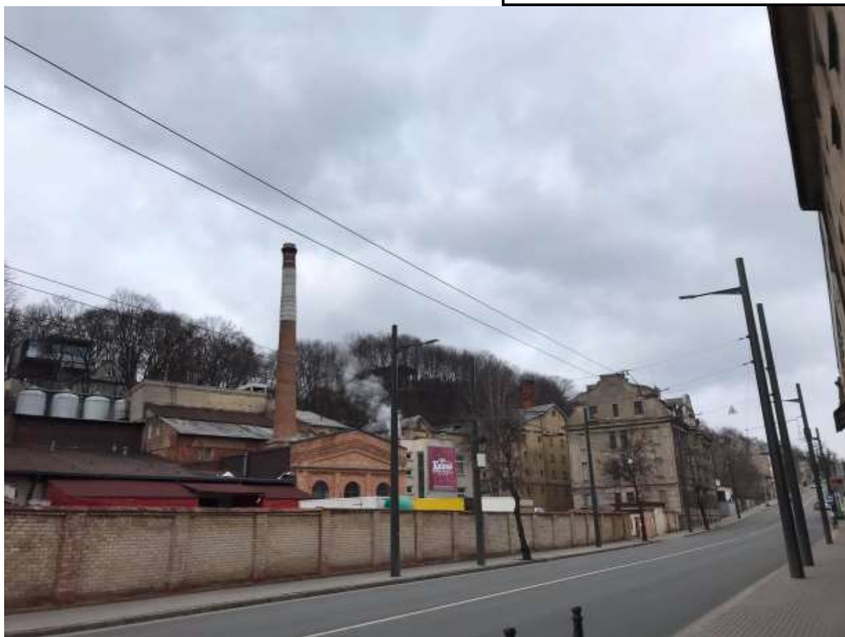
Nr. 1 Pavadinimas Raguvio alaus daryklos pastatų komplekso fragmentas Fotografavo Dovilė Miliukštė Data 2021-03-18
