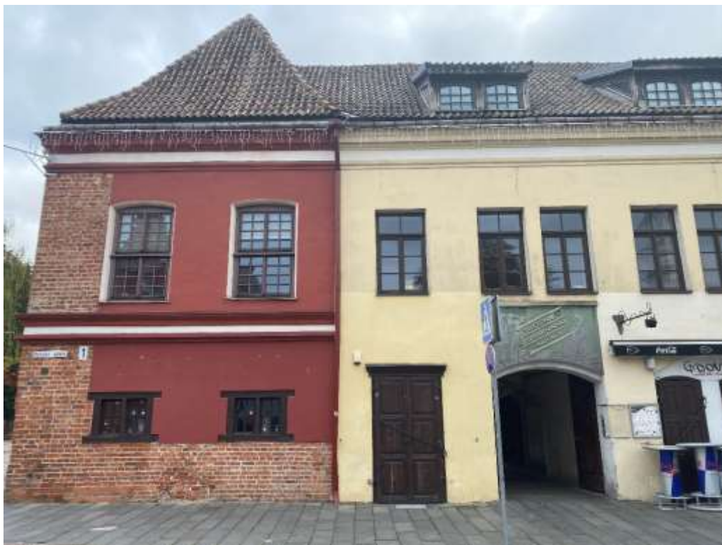
Nr. 5 Pavadinimas Pastato V fasadas Fotografavo Justė Martišauskaitė
