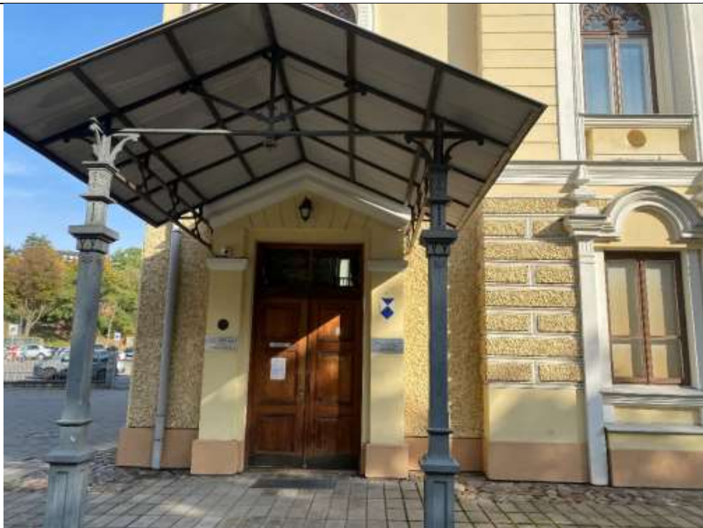
Nr. 4 Pavadinimas PV fasado fragmentas Fotografavo Justė Martišauskaitė
