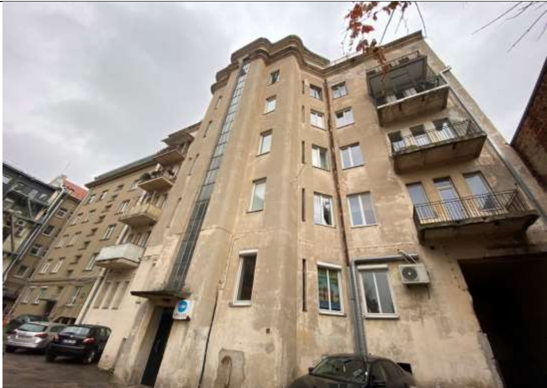
Nr. 2 Pavadinimas Verslininkų Mozės ir Malkos Chaimsonų namo V fasadas Fotografavo Vaiva Vyšniauskaitė Data 2020 – 10 – 29
