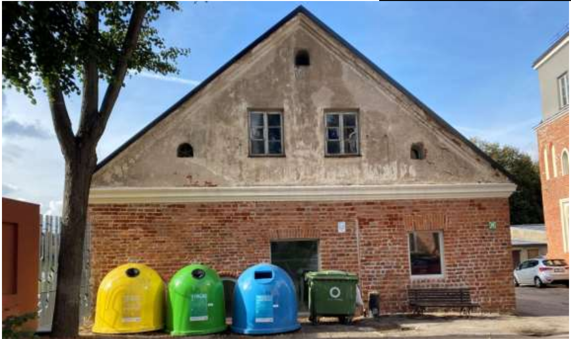
Nr. 1 Pavadinimas : Kauno bernardinų vienuolyno oficina, R fasadas
