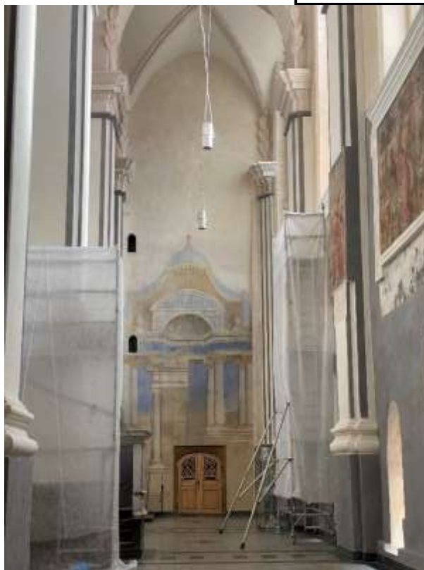
Nr. 7 Pavadinimas Bažnyčios vidaus tvarkybos darbai Fotografavo Vaiva Vyšniauskaitė
