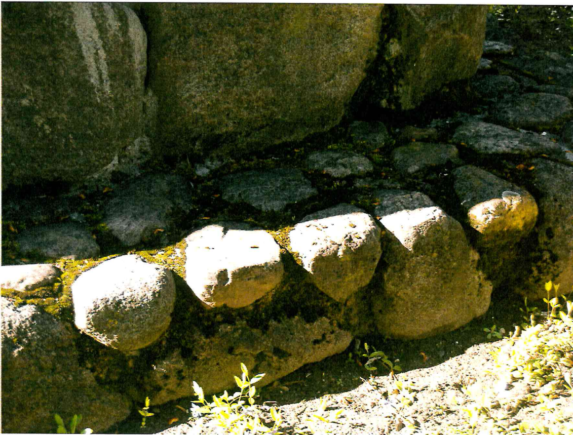
5 pav. Cokolis yra stabilus, tačiau daug kur pasidengęs samanomis ir kitokiomis apnašomis
