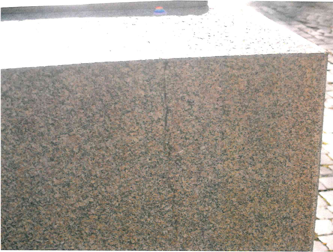
20 pav. Įtrūkimas aukuro galinėje dalyje
