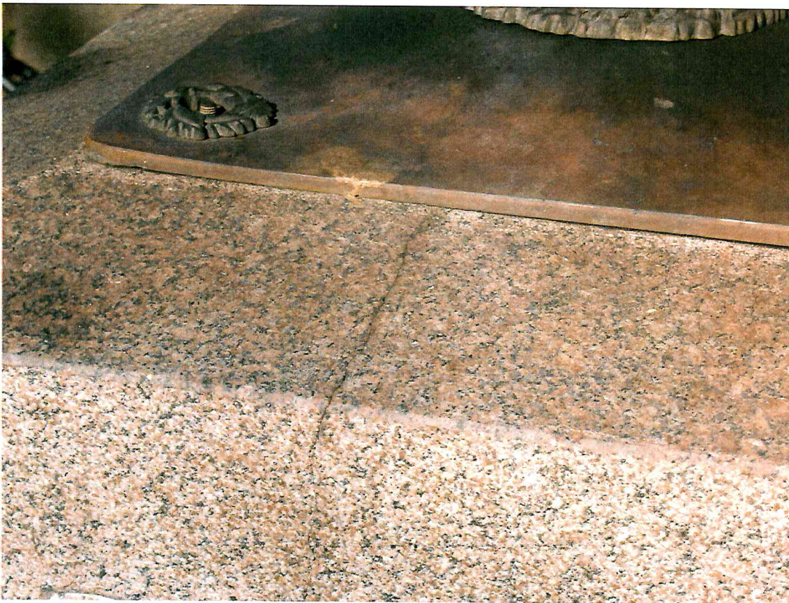
18 pav. Įtrūkimas aukuro priekinėje dalyje
