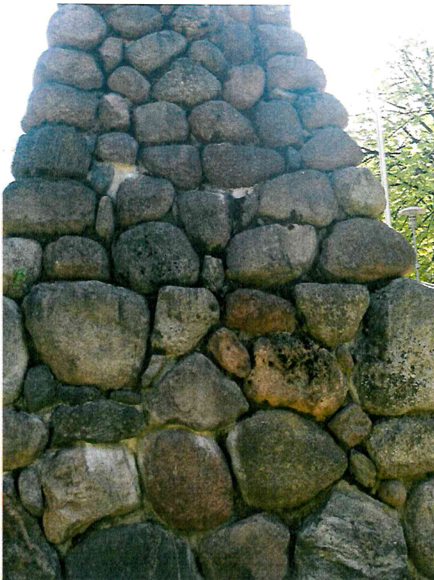
11 pav. Paminklo galinė siena padengta druskomis, samanomis ir kitais nešvarumais
