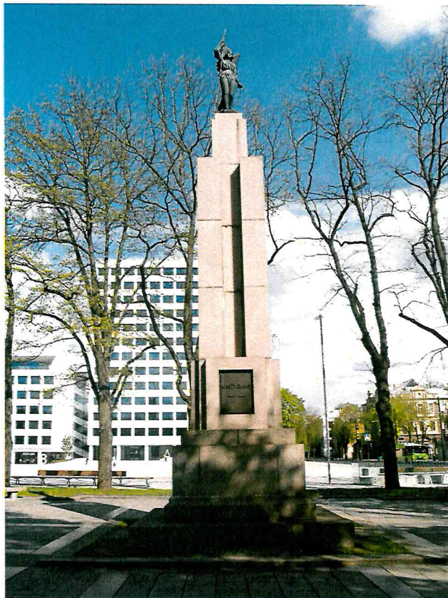
1 pav. Paminklo vaizdas iš priekio. Postamento viršuje matoma tamsi dėmė
