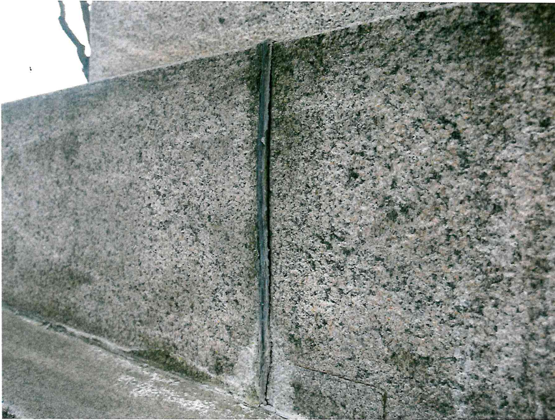
5 pav. Esamas hermetikas išstumtas į išorę, todėl nebėra sandarus. Siūlę būtina hermetizuoti iš naujo
