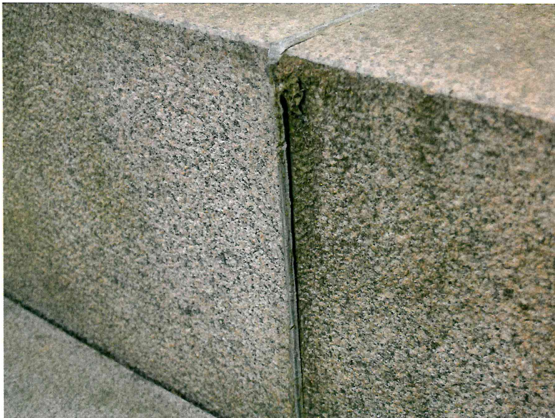
6 pav. Esamas hermetikas išstumtas į išorę, todėl nebėra sandarus. Siūlę būtina hermetizuoti iš naujo
