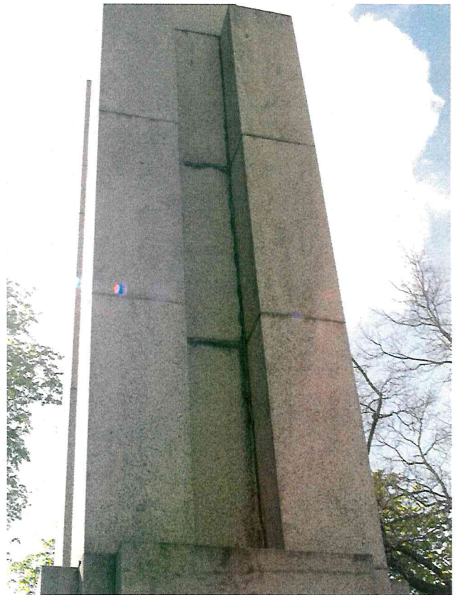
14 pav. Postamento ir kampinių iškišų sandūroje visos siūlės yra pajuodusios
