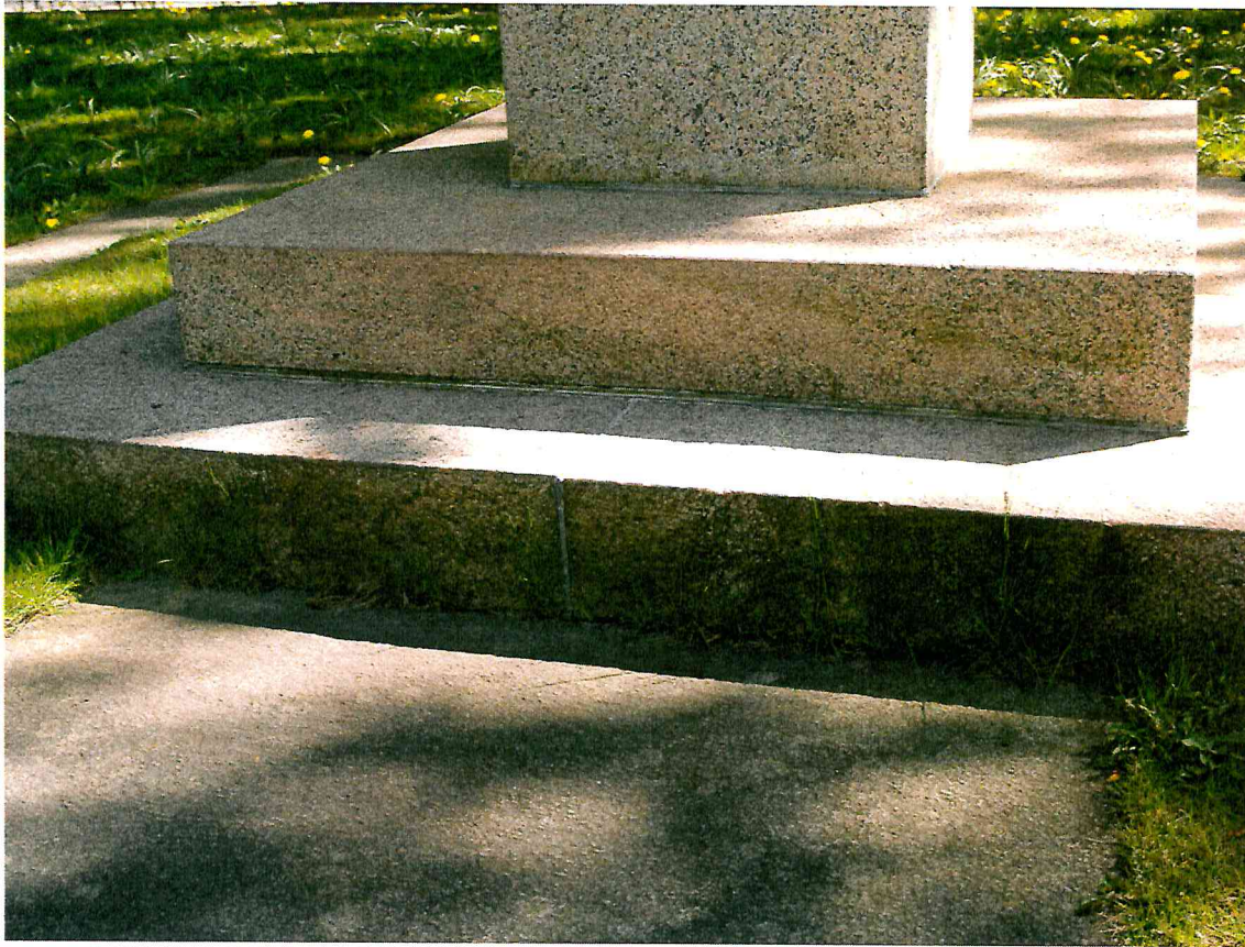
7 pav. Cokolio apatinis elementas stipriai padengtas žalsvomis apnašomis
