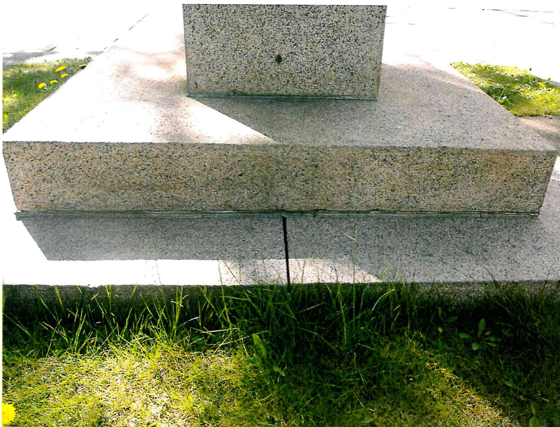
5 pav. Atvira siūlė tarp cokolio atskirų granito elementų
