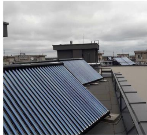
Ant stogo sumontuoti saulės kolektoriai.
