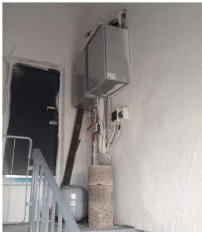
Saulės kolektoriaus ir šilumos siurblio vidinė dalis ir energijos apskaita. Pakeistos išėjimo į stogą durys.
