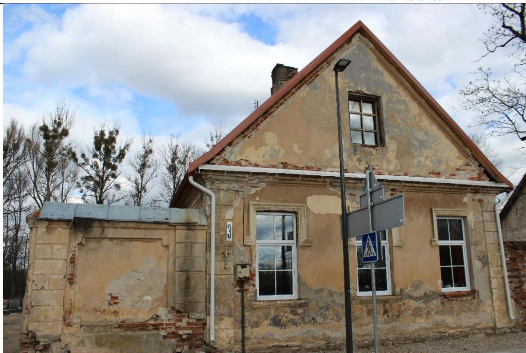
Nr. 2 Pavadinimas Aukštosios Fredos dvaro sodybos pirmo kumetyno fasadas iš PV pusės Fotografavo Germantė Maleckaitė Data 2019-03-12
