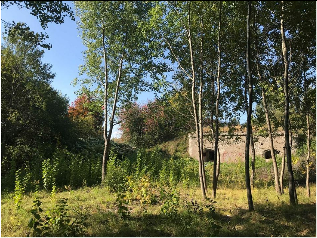
Nr. 6 Pavadinimas Fotografavo Dovilė Miliukštė Pirmo reduto aplinka Data 2019-09-27
