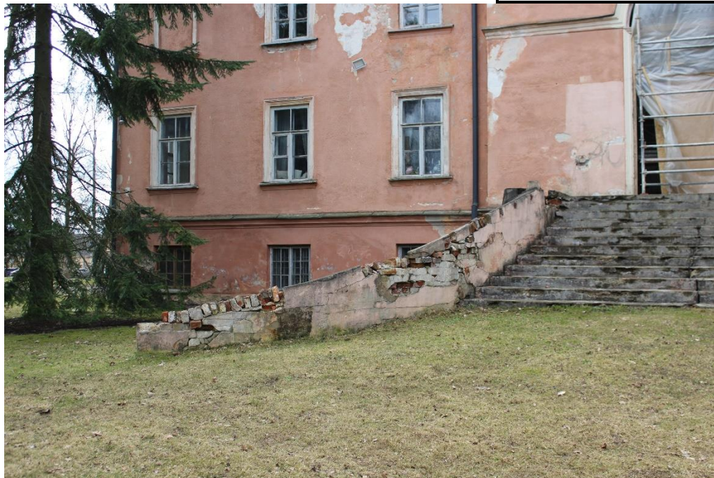
Nr. 13 Pavadinimas Aukštosios Fredos dvaro laiptai Š fasade iš ŠV pusės Fotografavo Germantė Maleckaitė Data 2019-03-12
