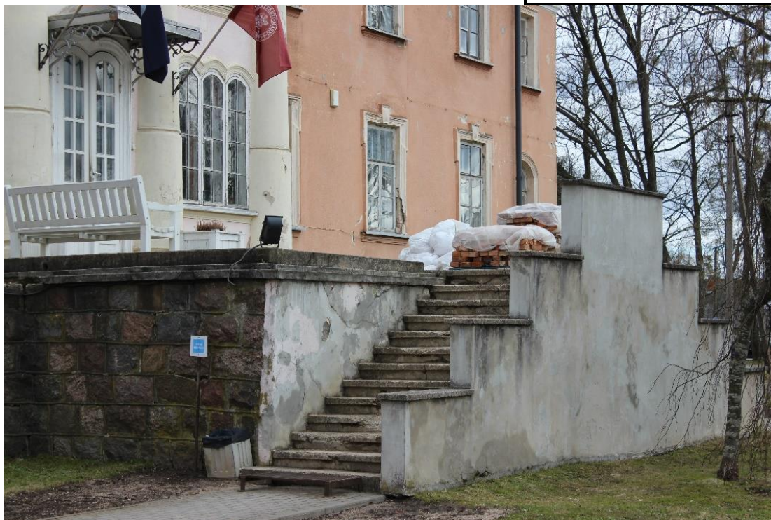
Nr. 23 Pavadinimas Aukštosios Fredos dvaro rūmų laiptai iš PV pusės, P fasade Fotografavo Germanė Maleckaitė Data 2019-03-12
