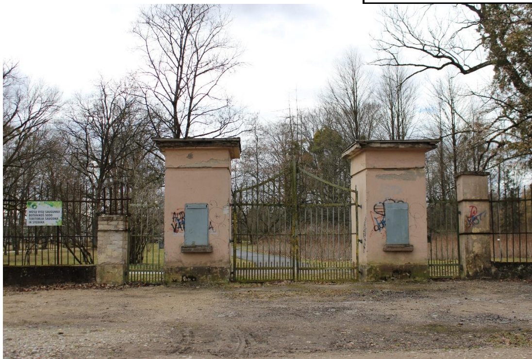
Nr. 1 Pavadinimas Aukštosios Fredos dvaro sodybos vartai, Š fasadas Fotografavo Germantė Maleckaitė Data 2019-03-12
