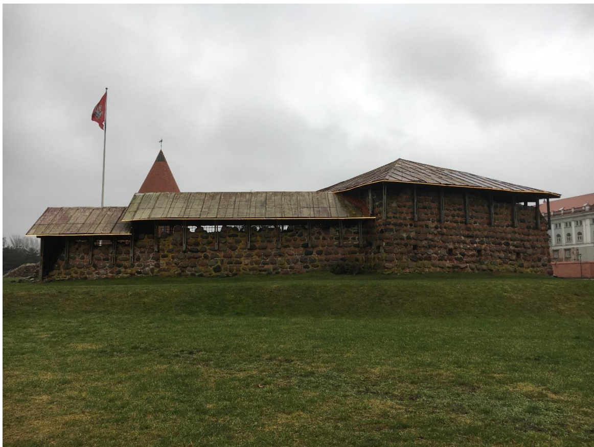
ŠV fasadas, PV bokštas (F-1)
