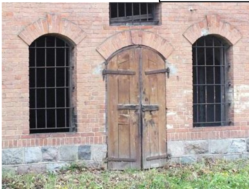
Nr. 5 Pavadinimas V fasado centrinė dalis su durimis ir langais
