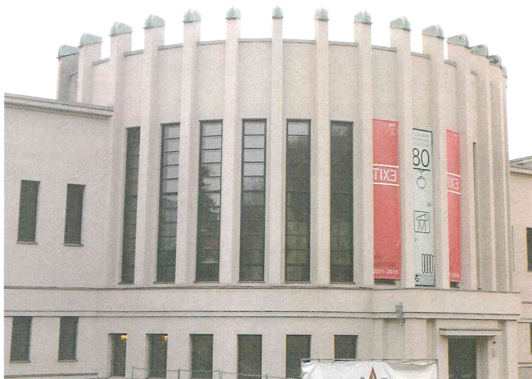
Nr. 14 Pavadinimas Puscilindrinė iškyša Š fasade, langai Fotografavo
