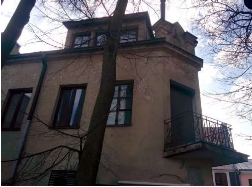
(F-7). PV korpuso frontonas.
