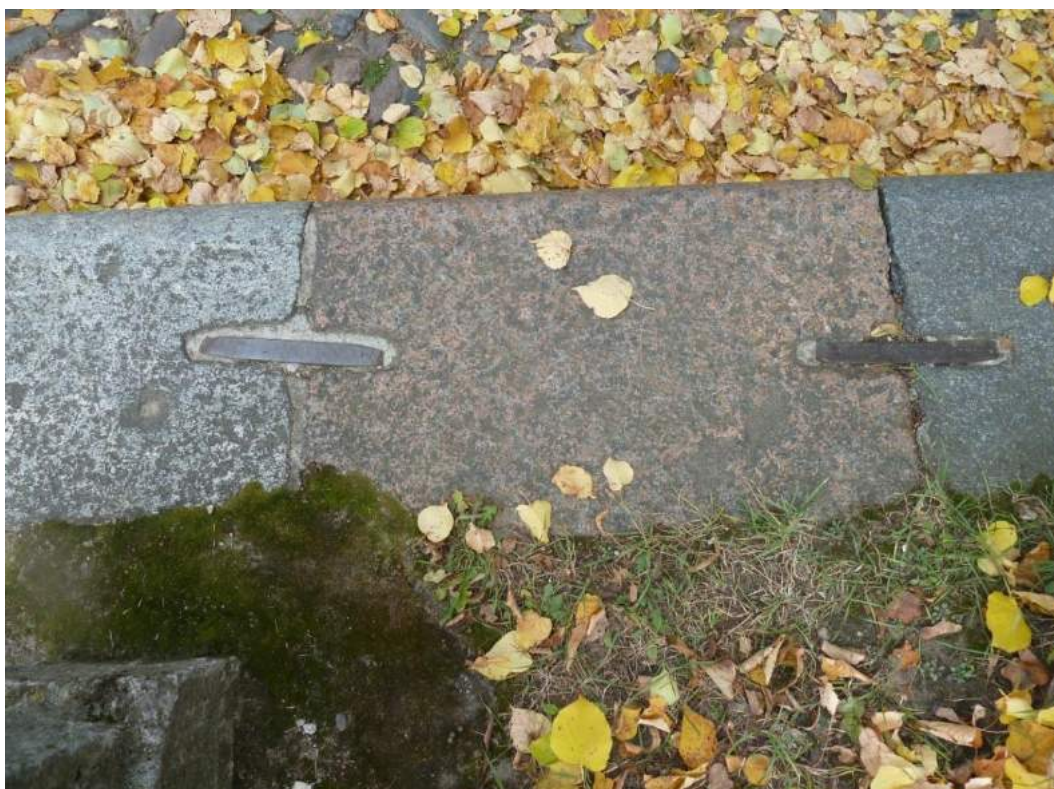
F4. Metalinės kabės granitinių karnizo plokščių tvirtinimui (S6) Fotografavo N.Steponaitytė. 2016-10-18
