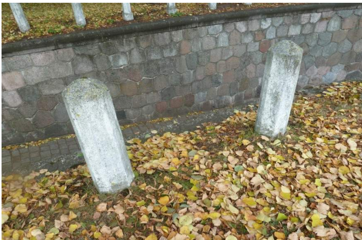
F6. Autentiški betoniniai stulpeliai (S8) Fotografavo N.Steponaitytė. 2016-10-18
