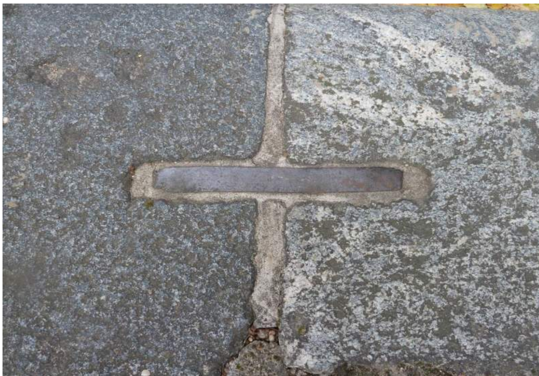
F3. Metalinės kabės granitinių karnizo plokščių tvirtinimui (S6) Fotografavo N.Steponaitytė. 2016-10-18
