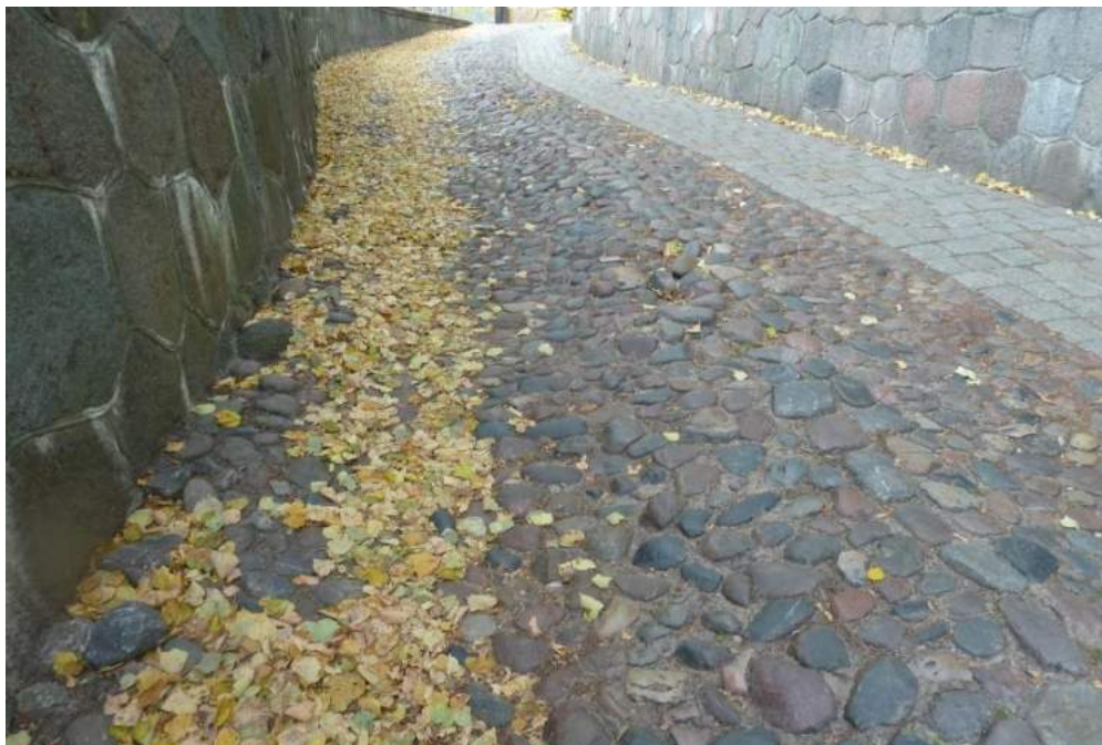
F1. Riedulių grindinys su įduba vandeniui nutekėti Prieplaukos g. (S4) Fotografavo N.Steponaitytė. 2016-10-18
