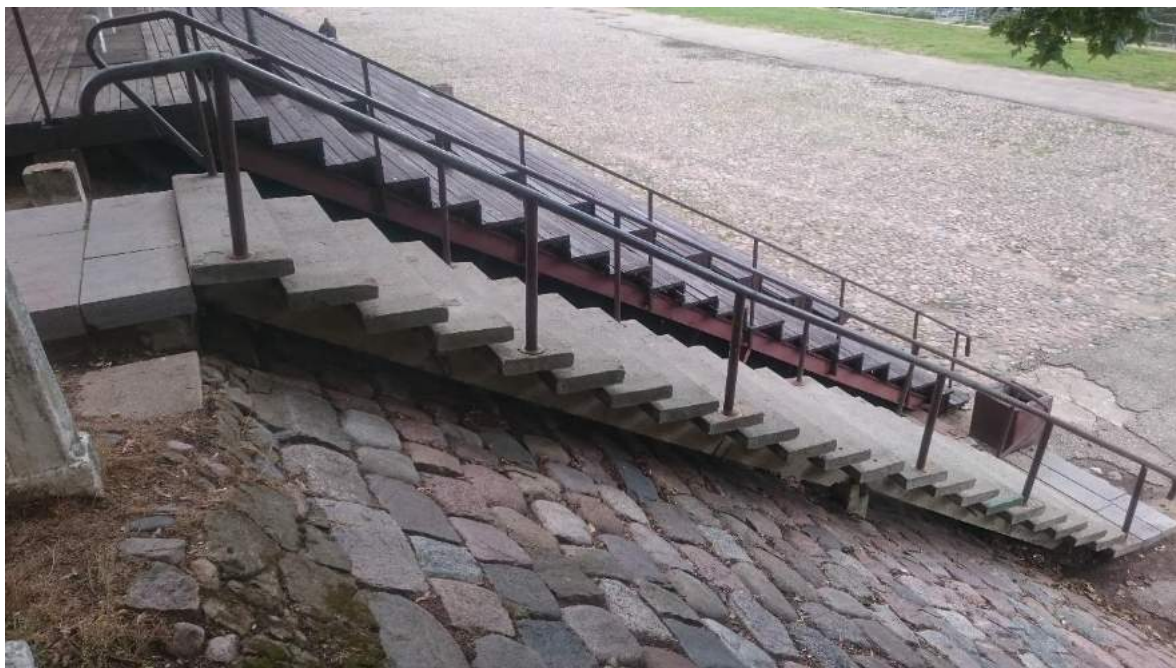
F23. XIX a. II p. tašytų akmenų Priekplaukos g. šlaito grindinys po amfiteatru (atkarpoje nuo A iki B) (S12, S16, S17) Fotografavo T.Rimas. 2016-08-04
