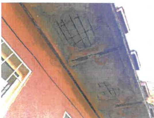
11 pav. Balkono plokštė
