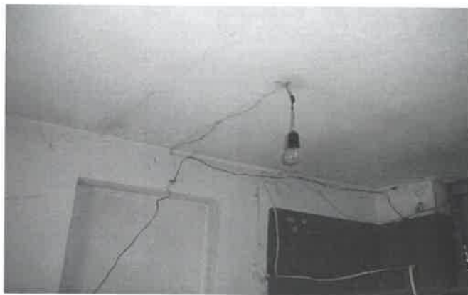
24 pav. Bendro naudojimo el. instaliacija
