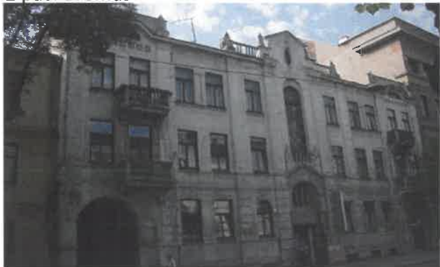
3 pav. Rytų fasadas
