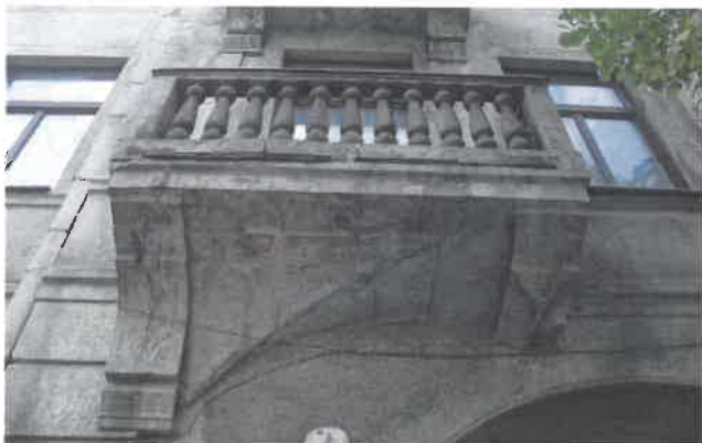
7 pav. Balkonas A. Mickevičiaus g. fasade
