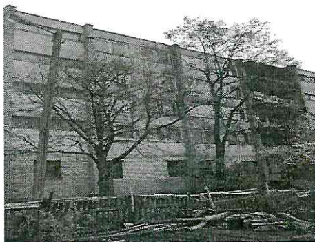
1 pav. Šiaurės vakarų fasadas
