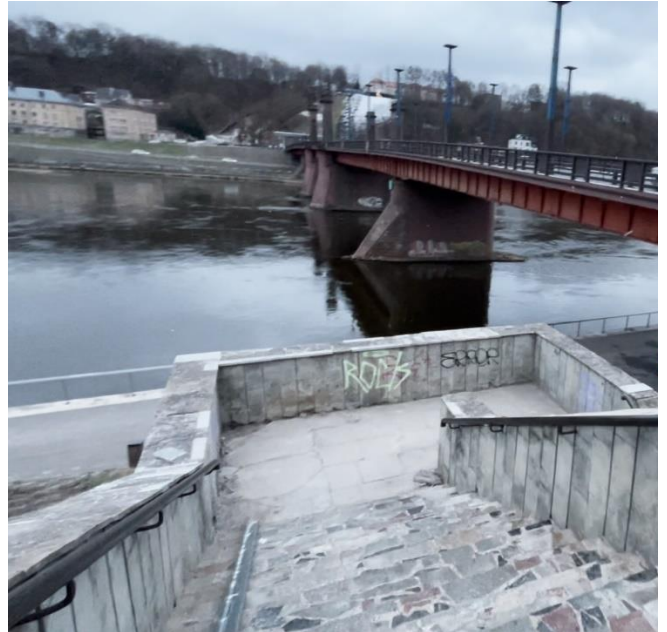
9. Nuo Karaliaus Mindaugo pr. laiptai link pėsčiųjų tunelio žiūrint Pietų kryptimi link krantinės. Laiptai iš granito dangos. Atraminių sienučių apdailos pažeistos, ištrupėjusios, atraminės sienutės sienos su įtrūkimais ir kitais pažeidimais. Neužtikrinimas žmonių su negalia tinkamas nusileidimas iki požeminės perėjos. Neužtikrinamas tinkamas apšvietimas saugiam patekimui į požeminę pėsčiųjų perėją.
