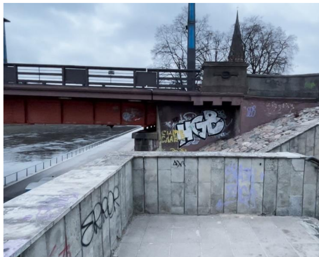
6. Sustojimo aikštelė laiptuose ties krantine žiūrint Vakarų kryptimi link Aleksoto tilto. Esamos betoninės plytelės su įtrūkimais, pažeistos, ištrupėjusios ir išlūžusios.
