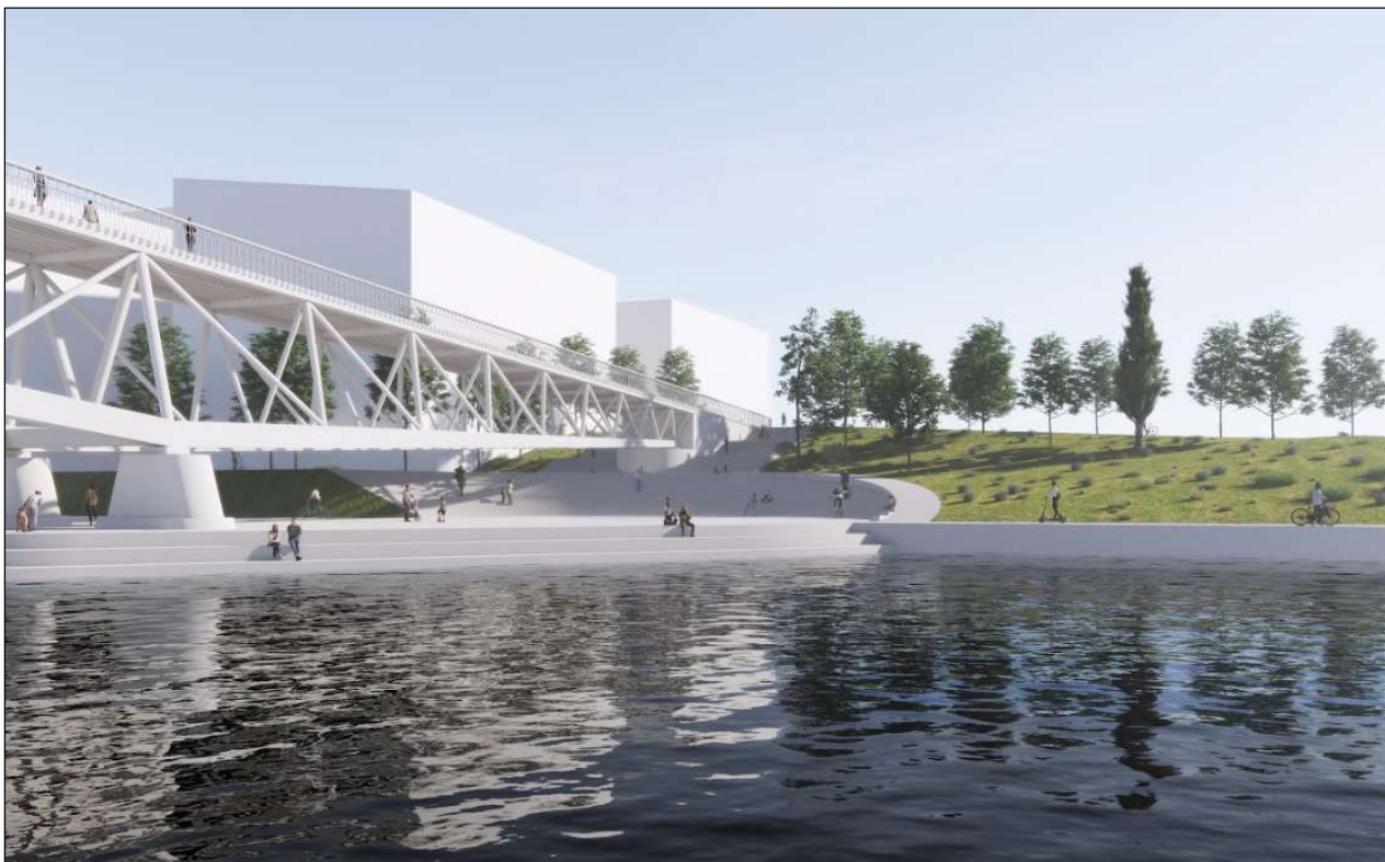
4 pav. Tiltų konstrukcijos vaizdai iš artimesnių rakursų
